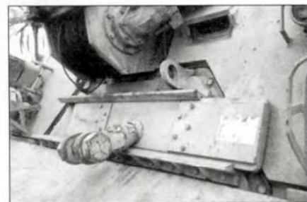
Направляющая троса 63,5-тонной основной лебедки.
