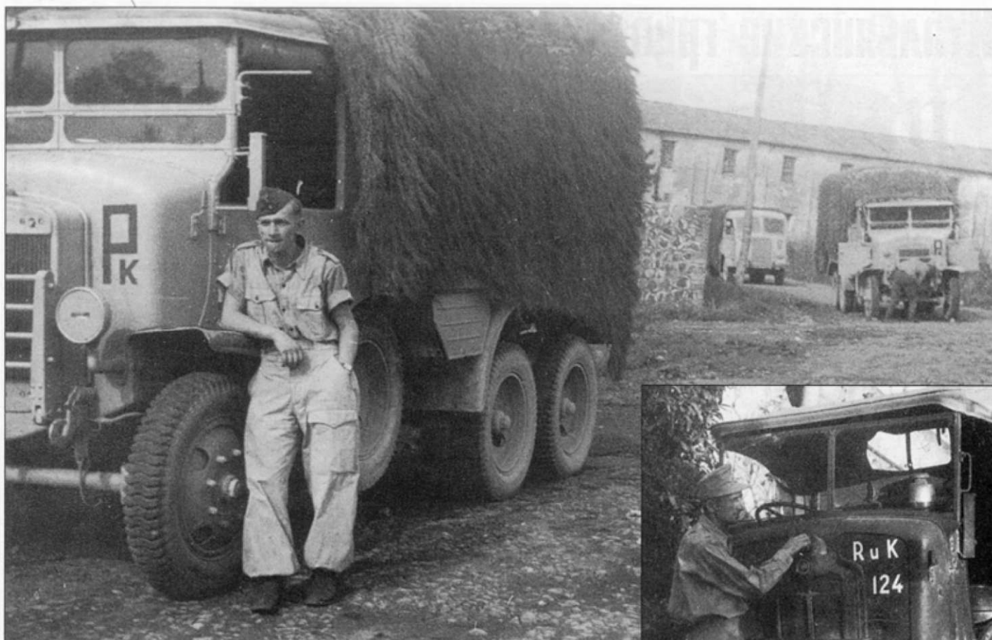
Два средних трехосных грузовика SPA Dovunque-35 (6x4), за ними - Фиат-626М. Грузоподъемность грузовика SPA Dovunque-35 составляла 2,5 т, а еще он был способен буксировать прицеп массой до 3,5 т.
