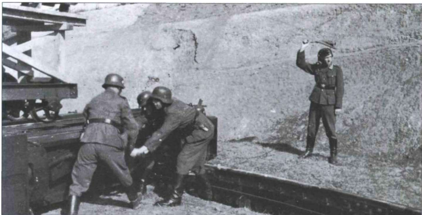
Для разворота 94-тонного орудия «Теодор Бруно» требовались усилия нескольких членов расчета, несмотря на наличие специального механизма. Офицер корректирует установку орудия по азимуту.
