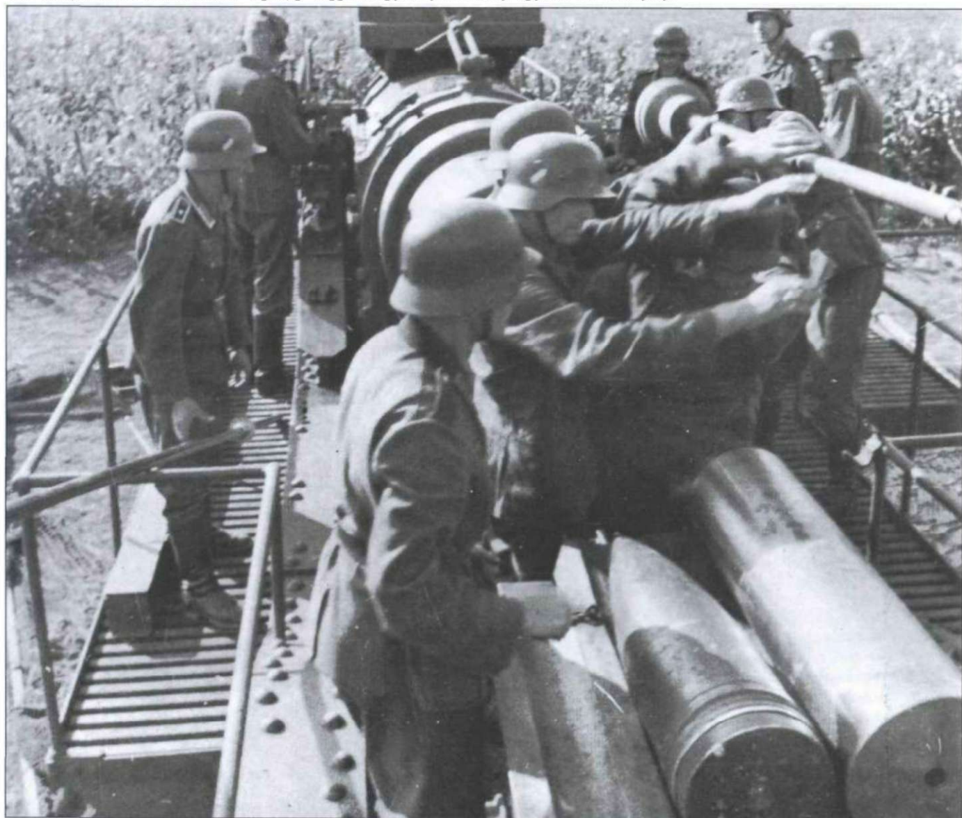
Из казенной части извлечен досылатель, осталось закрыть замок. На переднем плане - снаряд и заряд для производства следующего выстрела. Ствол установлен в горизонтальное положение. Заряжение производилось только при горизонтальном положении ствола.
