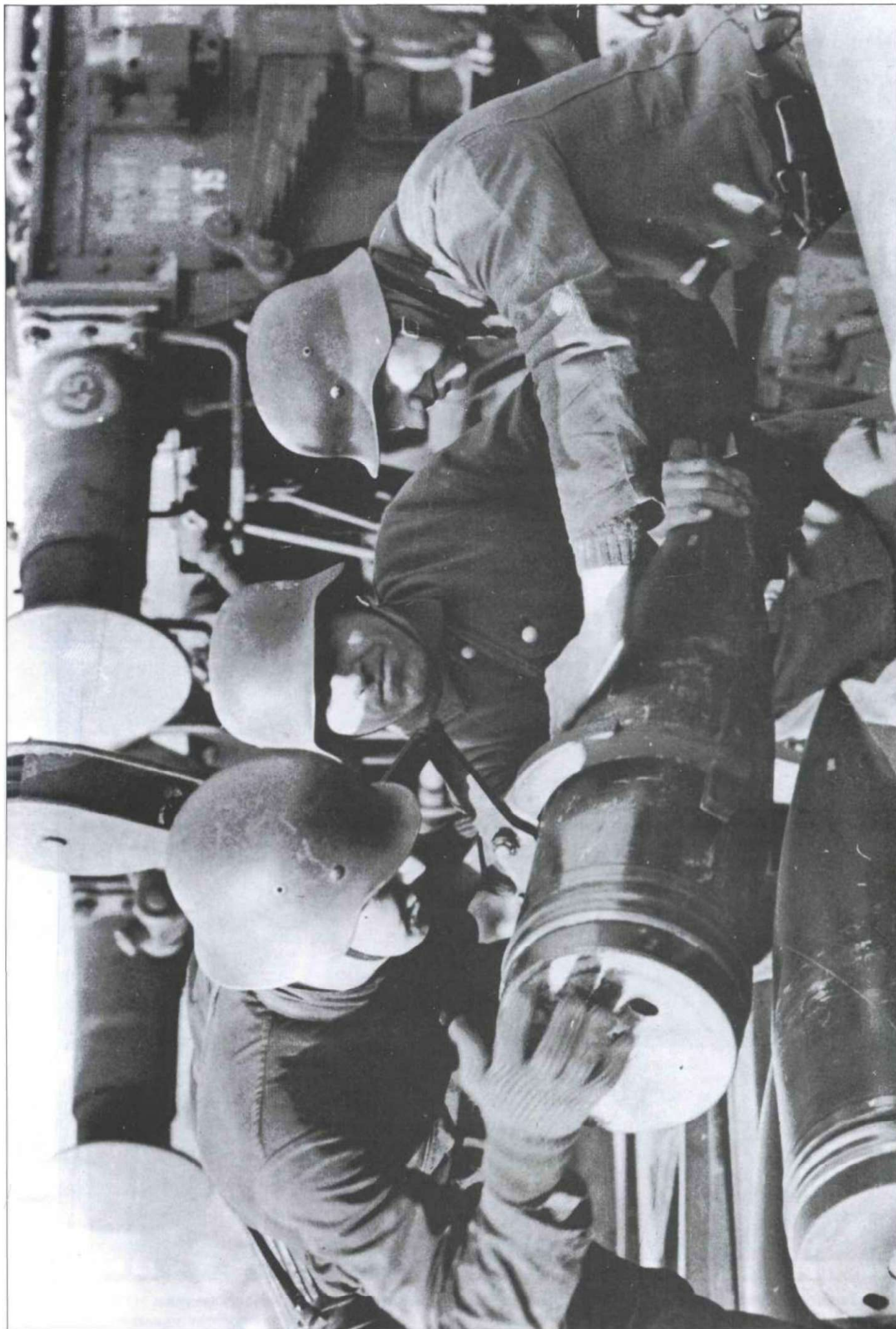
Заряжающие зацепили снаряд зацепами крана. Теперь снаряд будет поднят и уложен на ложе казенника пушки. Хорошо виден поясок снаряда. Поясок снаряда входит в каналы нарезов ствола, заставляя снаряд вращаться для лучшей стабилизации на траектории.
