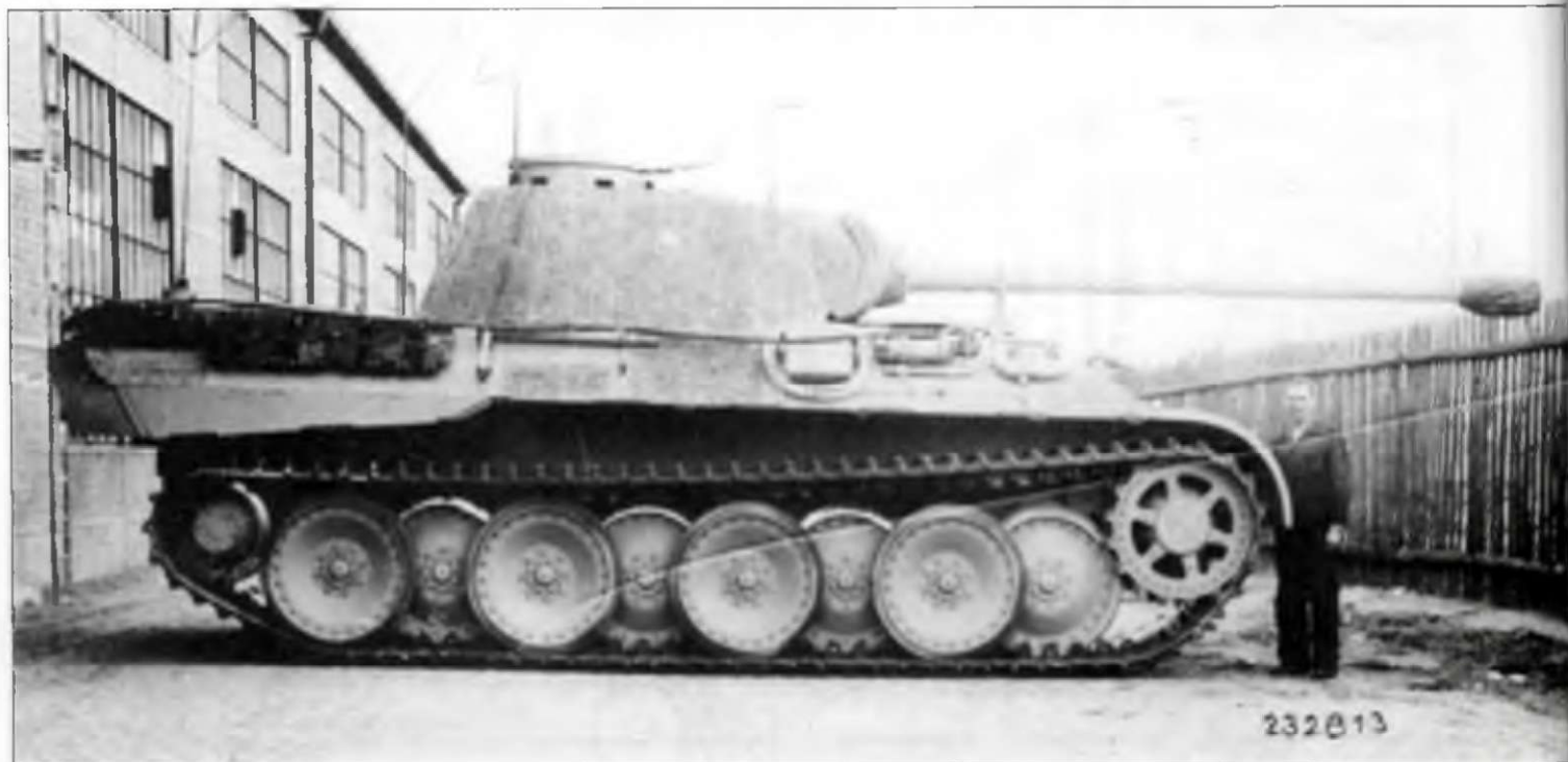
Р.-Вef.Wg Panther с циммеритным покрытием корпуса (собрана фирмой MAN в конце августа 1943 г. или в начале сентября того же года), снимок сделан возле здания сборочного цеха. Эти снимки «Пантеры» Ausf. D выпуска августа – сентября 1943 г. – пример отсутствия литой командирской башенки. «Пантеры» Ausf. A, построенные ранее ноября 1943 г., сохраняли pistolенные амбразуры в бортах башен и пулеметную амбразуру в лобовом броне листе корпуса.
