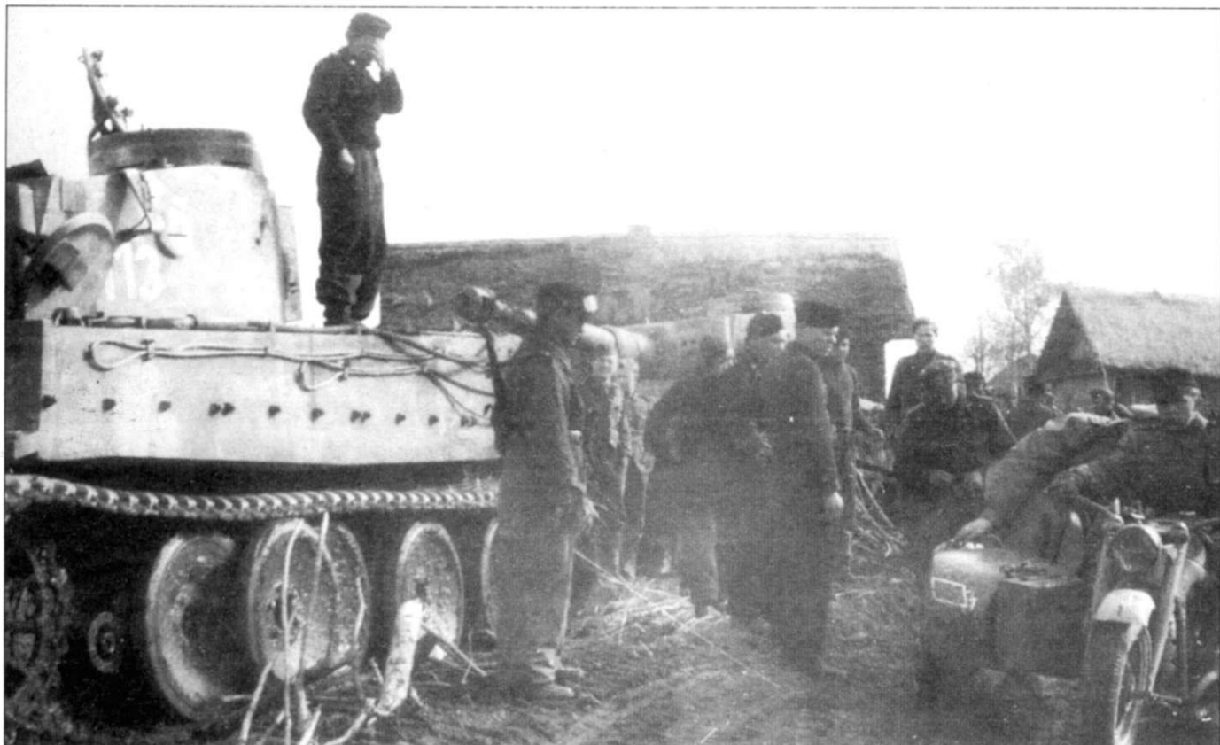
Тот же самый танк «3»- «14»- «113». Снимок сделан в небольшой российской деревушке, в которой местного населения уже не осталось. В начале весны 1943 г. все «Тигры» 502-го тяжелого танкового батальона перекрасили в песочно-желтый цвет. Одновременно изменили тактические номера, так номер «3» изменили на «14». На бортах корпуса появились болты для крепления секций крыла, однако самих секций в батальон так и не доставили.
