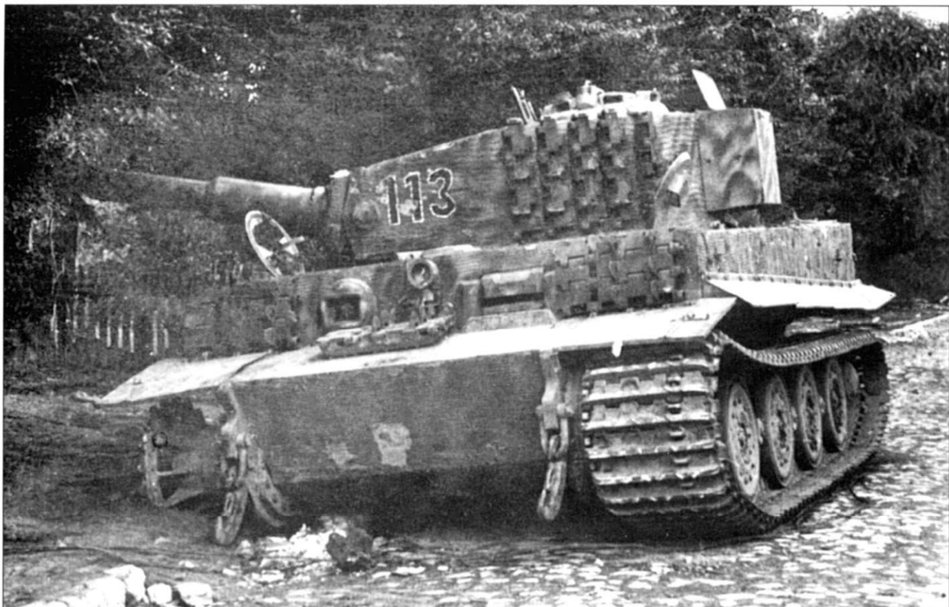
Подбитый в Звизнице Pz.Kpfw. VI Tiger Ausf. E позднего выпуска из 1-го взвода 1-й роты 506-го тяжелого танкового батальона. Машину с бортовым номером «113» удалось отбуксировать в тыл и отремонтировать. Обратите внимание на закрепленные на лобовом бронелисте С-образные крюки для буксировки.
