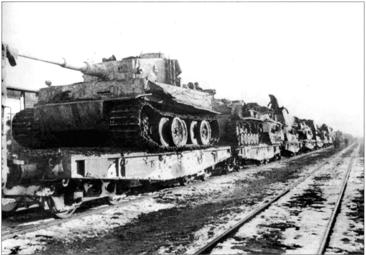
В крайнем случае «Тигры» допускалось перевозить на четырехосных железнодорожных платформах. За «Тигром» на платформах стоят штурмовые орудия StuG III.
