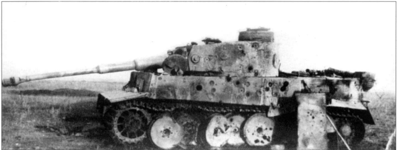
Изрешеченный «Тигр» из 505-го тяжелого танкового батальона. Здесь постарались штурмовики Ил-2, отбомбившиеся мелкими, но чрезвычайно эффективными, бомбами ПТАБ. Возможно, на корпусе имеются и отметки от артиллерийских снарядов. Курская дуга, июль 1943 г.
