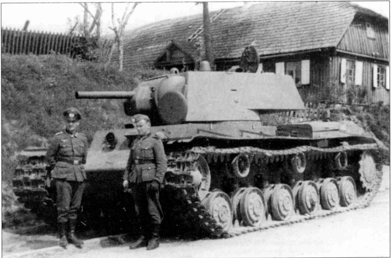
Танк KV-1 проекта 1940 г. ЛКЗ, ранних производственных серий, брошенный на обочине дороги. Несмотря на многочисленные переделки, на этих машинах так и не удалось полностью избавиться от проблем, связанных с ненадежной работой силовой установки, которые преследовали KV с самого начала их производства.
