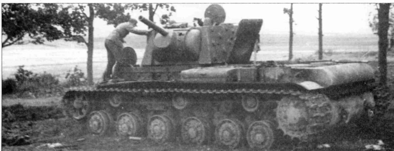
КВ-1 проекта 1940 г., поздних производственных серий (дополнительная наварная броня) с экранами (на корпусе и башне).
