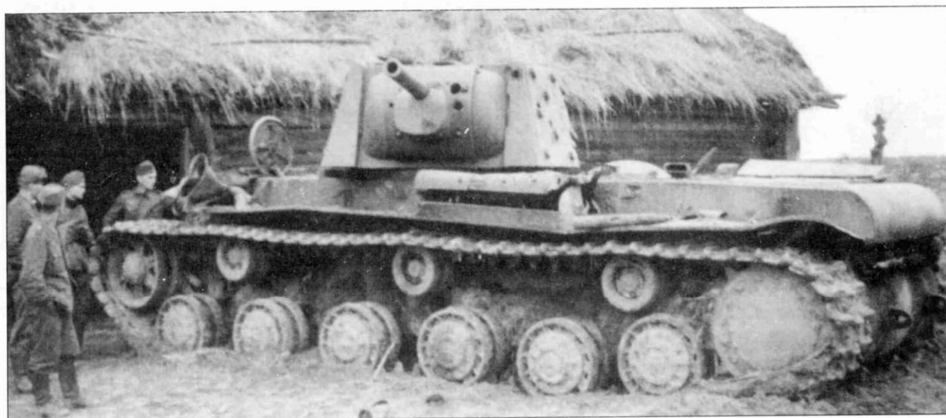
Три снимка танка KV-1 проекта 1940 г., ранних производственных серий с экранами (дополнительно бронирована только башня). Машина была подбита и остановилась около сарая. Согласно доступным фотодокументам, экранировались только KV-1 проекта 1940 г., вооруженные пушкой Ф-32.
