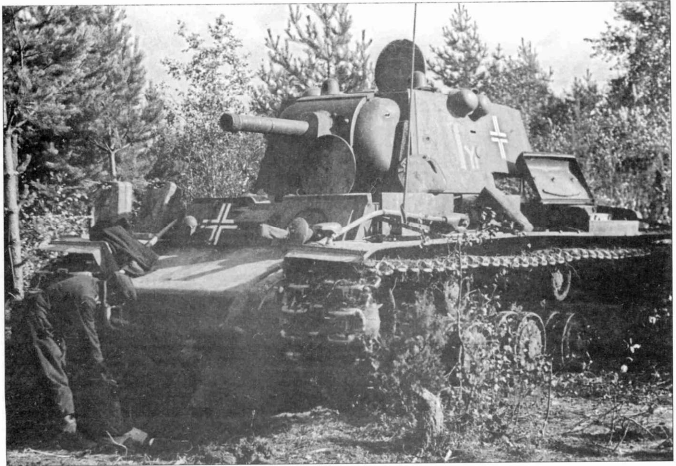
Panzerkampfwagen KV-1A 753 (r), бывший KV-I проекта 1940 г., поздних производственных серий обслуживается немецким экипажем на опушке леса. Немцы уже успели установить на этот танк фару для вождения в темное время суток Notek.
