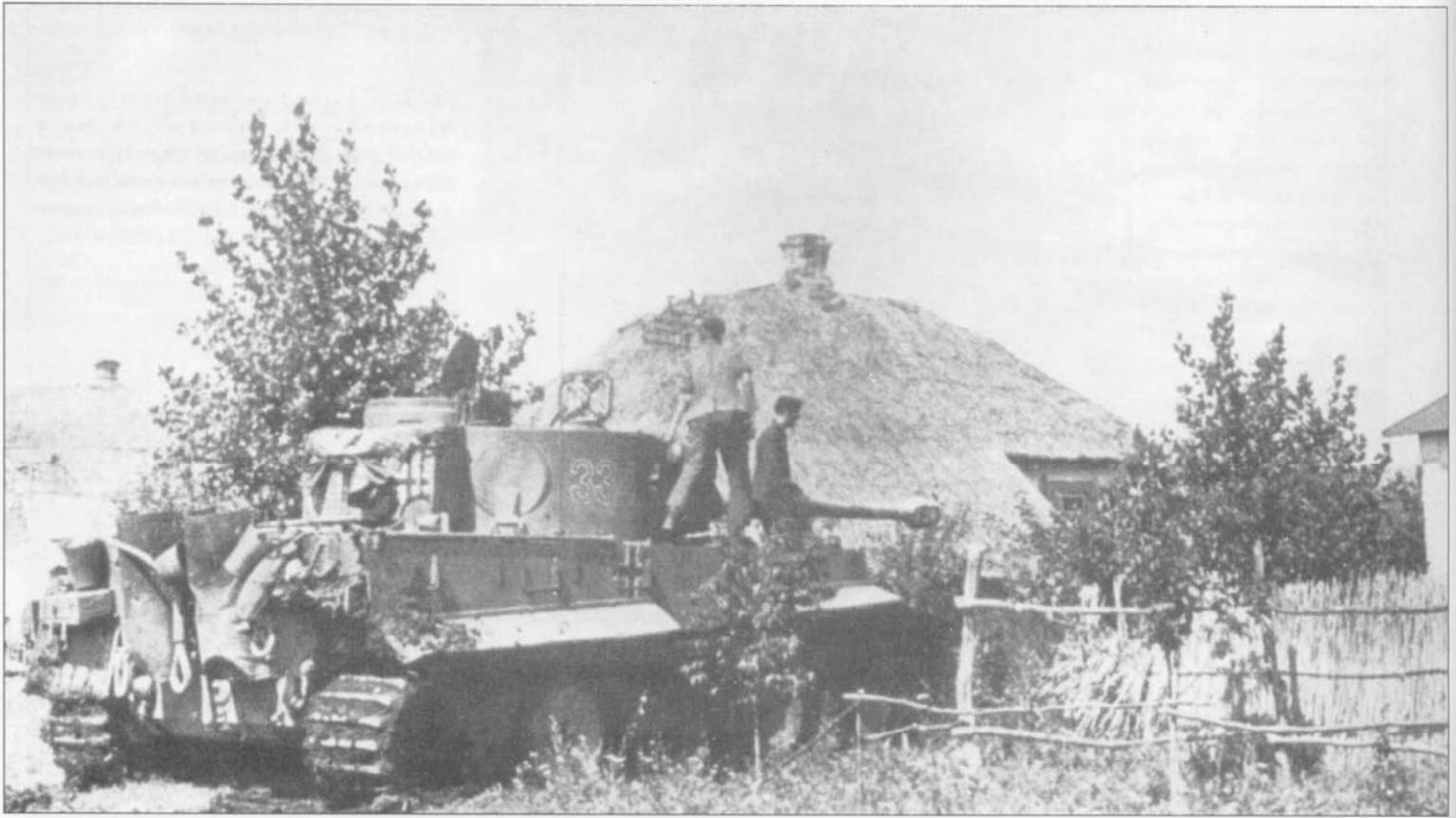
Танк Pz.Kpfw. VI «Тигр» с бортовым номером «334». Опознавательные знаки в виде крестов нанесены на борта и кормовую стенку башни, на борта корпуса. На корме уложен нацистский флаг - средство быстрого опознавания с воздуха. Танк оснащен дымовыми гранатомерами. Корпус машины камуфлирован мелкими пятнами оливково-зеленого цвета, на башне пятна камуфляжа крупнее.
