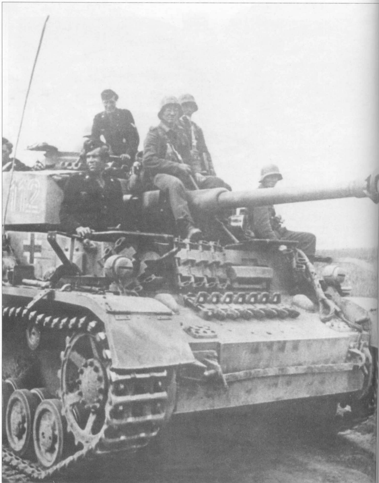
Танк Pz.Kpfw. IV Ausf. H. На броне устроилось несколько пехотинцев. Обратите внимание на кронштейн для крепления бортового экрана, самого экрана нет. Как правило, на танках оставались только экраны, прикрывавшие с бортов башню. Цифры тактического номера «112» на борту башни написаны только контуром белой краской, такое написание цифр типично для осени 1943 г.
