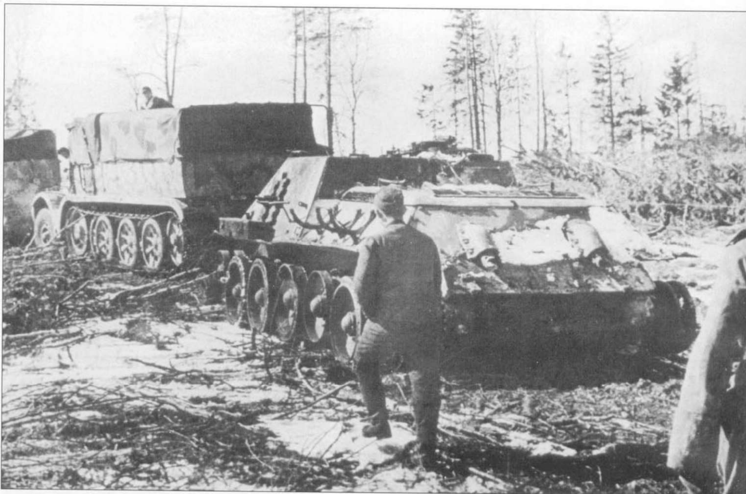
Два полугусеничных тягача Sd.Kfz. 7 буксируют подбитую советскую самоходно-артиллерийскую установку СУ-122. Обратите внимание на камуфляжную окраску ближайшего к самоходке тягача, рисунок камуфляжа собственно тягача и тента различен.
