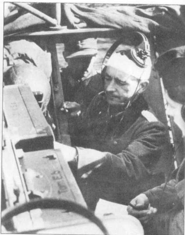
Радист за работой. Снимок дает представление о тесноте боевого отделения радиомашинны Sd.Kfz. 250/3 Neu. Эти радиомашинны обеспечивали связь наземных войск с авиацией, на некоторых из них вместо огромных поручневых антенн стояли штыревые антенны с «метелкой» на конце.
