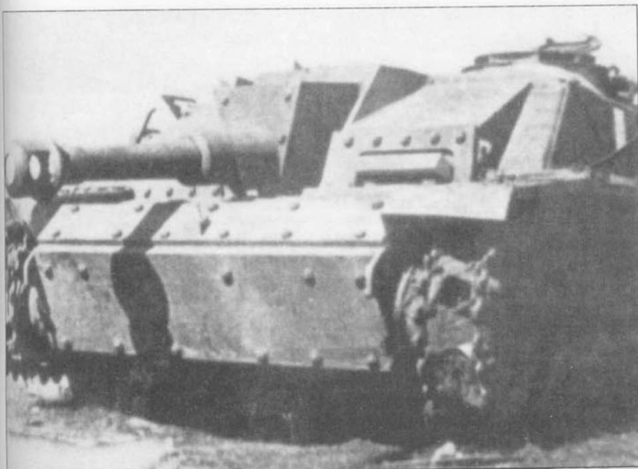
Подбитая самоходка StuH-42 Ausf. G. Вооруженные пушками 10.5 см StuH-42 L/28, эти машины состояли на вооружении бригад штурмовых орудий, где использовались для огневой поддержки. От штурмового орудия StuG III Ausf. G самоходки StuH-42 Ausf. G отличались только вооружением.
