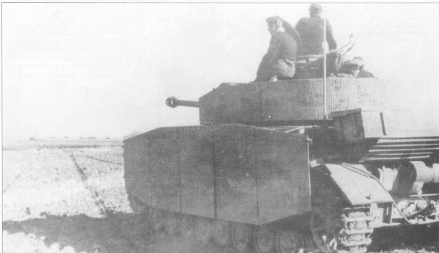
Танк Pz.Kpfw. IV Ausf. H, машина целиком покрыта циммеритом. Обратите внимание на огромный нестандартный ящик для имущества, закрепленный на крыше моторного отделения. Осенью 1943 г. немецкие войска отступали по всему Восточному фронту. Красная Армия на фронте от Смоленска до Ростова располагала 2600 танками. До конца года эта сила отбросила германцев на рубеж Днепра.
