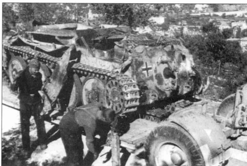
Шасси самоходки погружено на автомобильный транспортер Sd.Afh. 115 для перевозки в ремонтную мастерскую.
