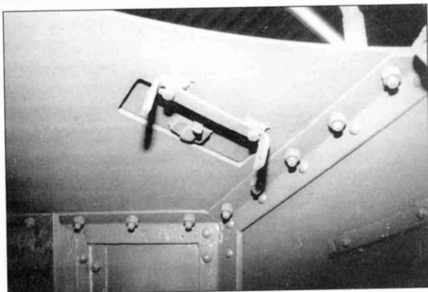
Вид изнутри на лючок в крыше рубки.
