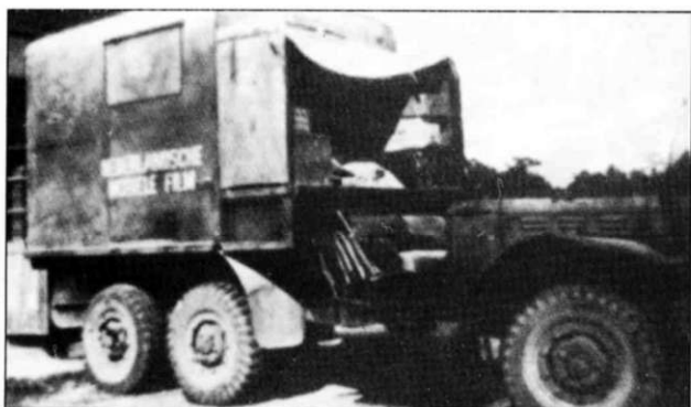
Голландские вооруженные силы использовали некоторые из Dodge T22 в качестве пожарных машин на полевых аэродромах ВВС. На снимке пожарная машина на аэродроме в Голландской Ост-Индии, 1947 г. Фургон в тыльной части кузова взят от грузовика GMC.
