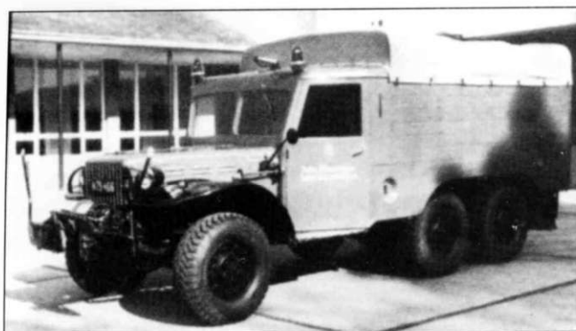
Рукавный автомобиль - Rüstwagen (фургон для перевозки рукавов, насосов и пожарного оборудования) пожарной школы в Нижней Австрии, сфотографированный в 1971 г.
