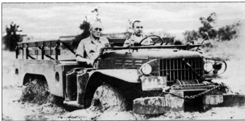
Инженеры «Chrysler Corporation» испытывают Dodge T223 - WC63 "Big Shot" на бездорожье фирменного полигона. На оригинальной фотографии под дугой на номерном знаке можно было рассмотреть цифру года - 1942.
