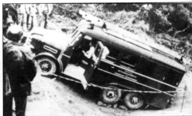
Сильно измененный австрийский Dodge 6x6 с кузовом пожарного автомобиля преодолевает пересеченную местность. Снимок 1981 г.
