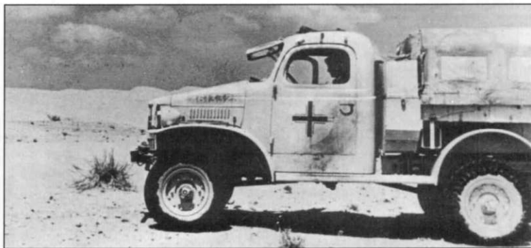
Два Dodge T212 канадского производства стали трофеями немцев. Северная Африка, 1942 г. Характерная «канадская» черта, отличающая машины от аналогичных грузовиков американского производства - двойной ящик позади кабины. На левом снимке машина без люка на крыше кабины, справа - с люком. Эта деталь добавлена уже в Африке в местных полевых мастерских.
