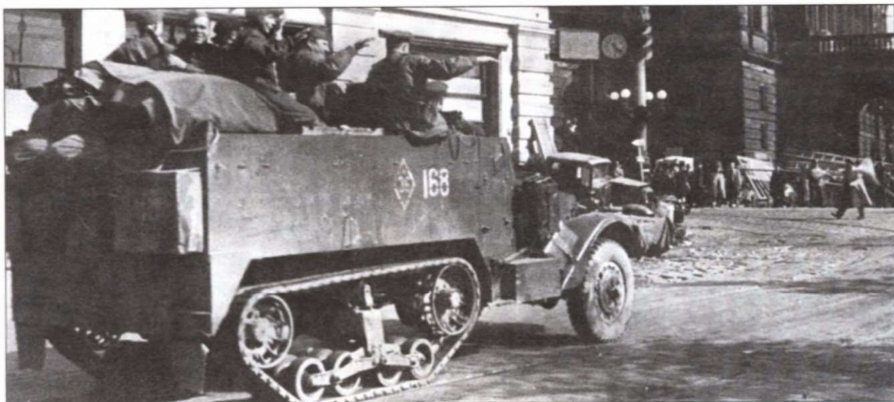
Самоходка СУ-57 (советское обозначение американской машины T-48 57mm Gun Motor Carriage) движется по улице Праги, май 1945 г. Знак бригады на борту машины нанесен желтой краской. Tактический номер белого цвета продублирован в корме и на носу. На других снимках этой же самоходки видно, что на капоте двигателя нарисован белый треугольник - знак быстрого опознавания.
