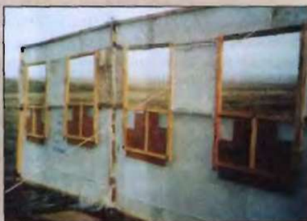
■ Вид сзади. Хорошо видна конструкция окна
