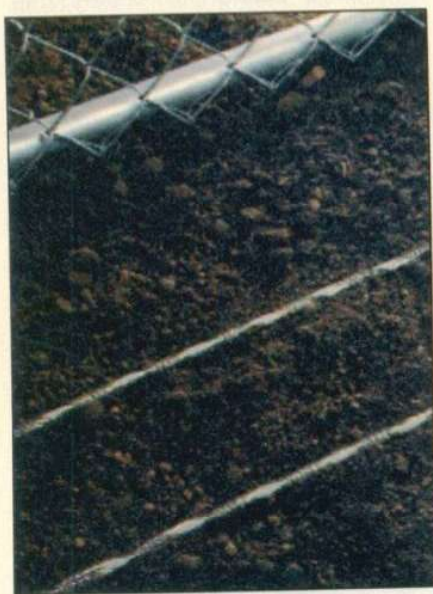
Поле, создаваемое системой, простирается и в грунт, что исключает возможность преодоления его путем подкопа
