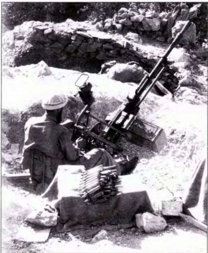
Одним из главных средств ПВО душманов на протяжении всей войны оставались советские 14,5-мм зенитные пулеметные установки ЗПУ-1 и их китайские копии типа 75 (на снимке).
