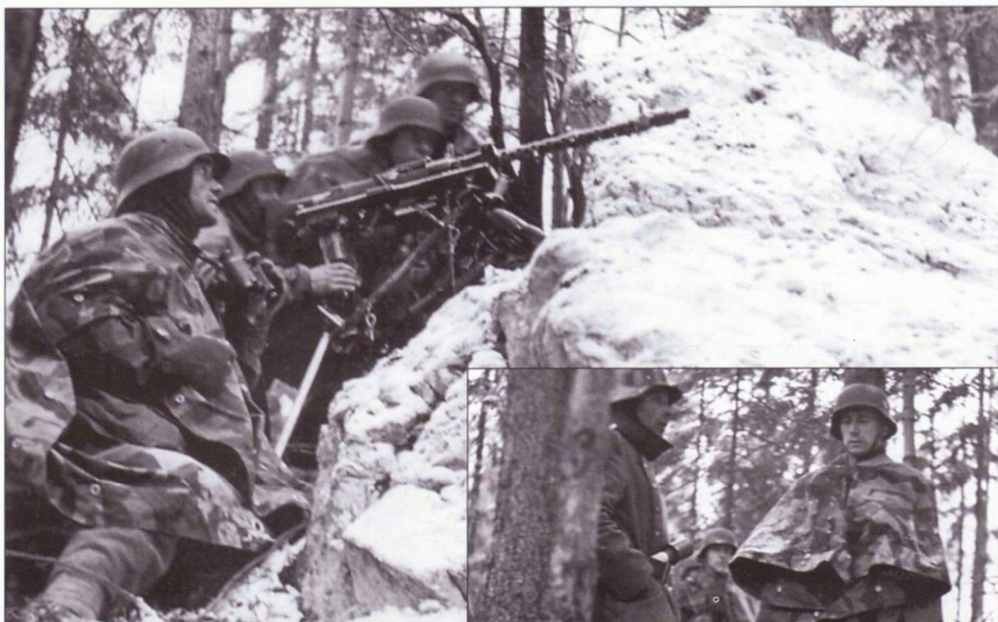
Расчет станкового пулемета MG34. MG34 фактически являлся «единым» пулеметом: на сошках - ручным, на треноге - станковым. В станковом варианте пулемет комплектовался оптическим прицелом. Станковый пулемет также снабжался тремя - четырьмя запасными стволами. Ручной пулемет - всего одним запасным стволом.
