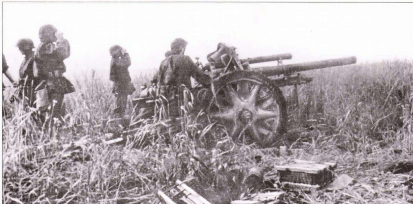
Легкая полевая гаубица 10.5 см I.FH18 артиллерийского подразделения СС на огневой позиции, Восточный фронт. На переднем плане - тара от снарядов и зарядов. Все артиллеристы одеты в камуфлированные куртки, что вообще сильно странно - артиллеристы почти никогда не носили камуфляж, который в первую голову предназначался для пехоты.
