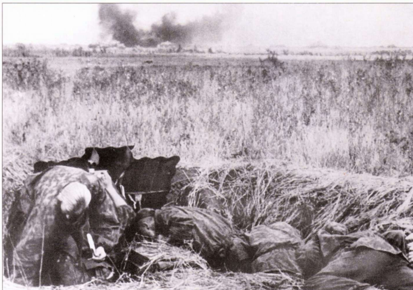
Расчет легкой пехотной пушки 7,5 см LIG18 укрылся от обстрела в окопе. На вооружении роты тяжелого оружия (13-я рота) пехотного полка имелось от четырех до шести таких пушек. Верхний срез щита пушки выполнен волнистым, чтобы прямая линия не бросалась в глаза на местности. Бруствер окопа замаскирован травой. Дно также завалено травой, чтобы окоп сложнее было обнаружить с воздуха.
