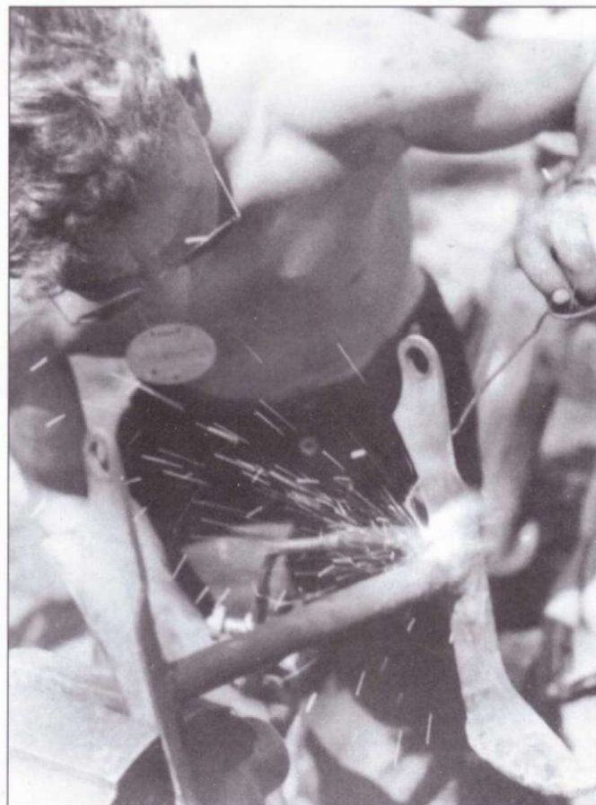
Сварка в полевых условиях была совершенно необходима для ремонта поврежденной боевой техники. От «зайчиков» сварщик закрылся темными очками. Сварщик работает без рукавиц, чем явно нарушает инструкцию по безопасности труда. На груди сварщика болтается медальон с личным номером и группой крови. В случае гибели воина, его боевые товарищи отламывают нижнюю половинку медальона и доставят ее в штаб подразделения, верхняя половинка с цепочкой остается на теле убитенного. В пехоте медальоны прозвали «собачьими бирками», Hundemarke.
