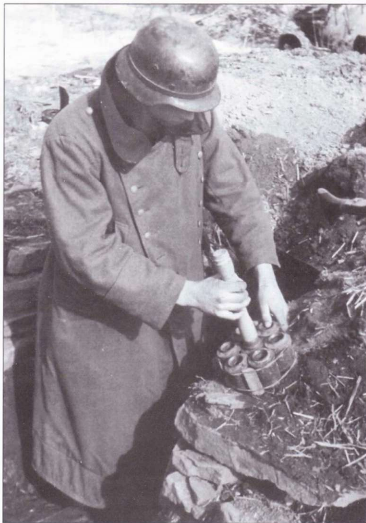
Гренадер приготовит связку ручных гранат – известное средство борьбы с танками или для подрыва бункеров. Шесть гранат без ручек обвязаны вокруг одной с ручкой. Связку гранат старались забросить на крышу башни или на крышу моторного отделения танка. При удачном попадании такая связка пробивала броню толщиной до 60 мм. Солдат стоит в мелком окопчике.
