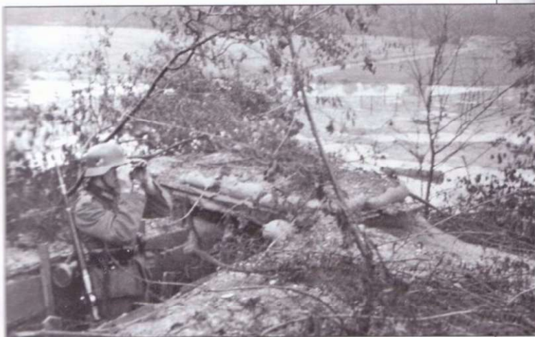
Наблюдательный пункт (Beobachtungsstelle) устроен на крутом речном берегу. Наблюдательный пункт выложен мешками с песком, засыпан грунтом и замаскирован срубленными деревьями и ветками. Мешки с песком – традиционный способ укрепления земляных сооружений со времен первой мировой войны. Для строительства блиндажей, землянок и пр. часто разбирали деревянные дома, так называемые «Isb'ы».
