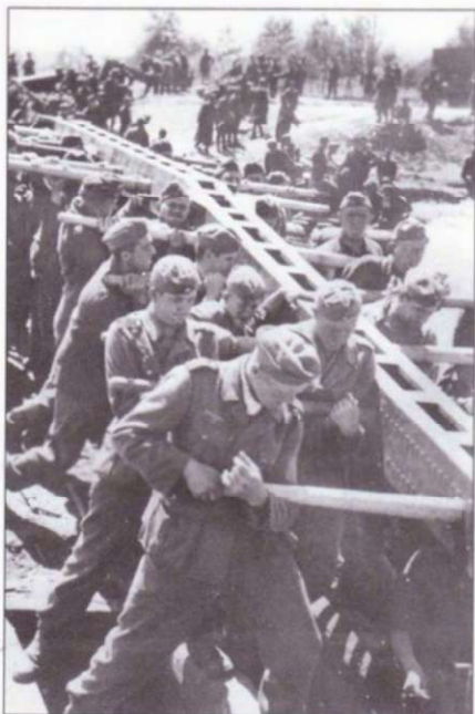
Саперы собирают из готовых стальных секций мост Bruckengerat-K. В зависимости от типа используемых секций, длина пролета моста «К» могла достигать 19 м. Более длинные мосты собирались в варианте с промежуточными опорами. Однопролетный мост выдерживал нагрузку в 27 т. Чаще всего мосты «К» наводились над оврагами и рвами, в случае организации мостовой переправы через водные преграды секции моста «К» использовались как часть понтонного моста.
