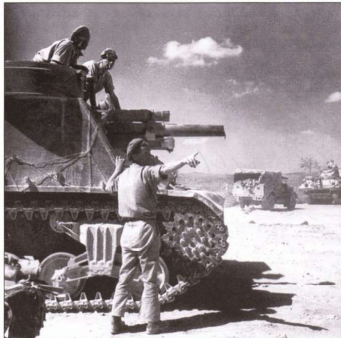
Самоходная гаубица «Прист», Готская линия, 3 сентября 1944 г. Это машина раннего выпуска с симметричными подкрылками и тележками опорных катков без облегчающих отверстий. На заднем плане - грузовик Бедфорд и истребитель танков M10.
