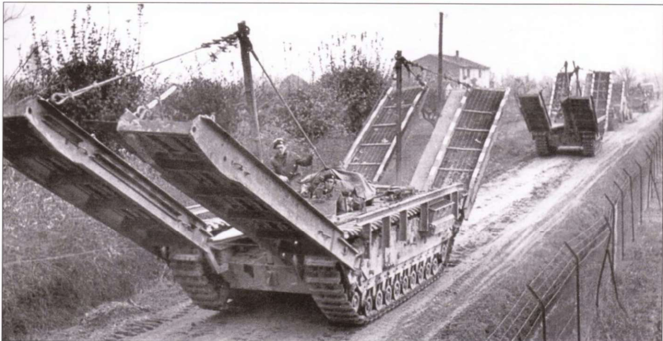
Мостовкладчики на базе «Черчиллей» по дороге к Форли, 9 ноября 1944 г. Обратите внимание на белые полосы, нанесенные на пандусы моста.
