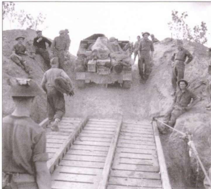
Понтон достиг берега реки Вольтюрно - «Карриеры» двинулись дальше. Проход в береговом склоне проделан саперами из 272-й полевой роты Королевского инженерного корпуса.
