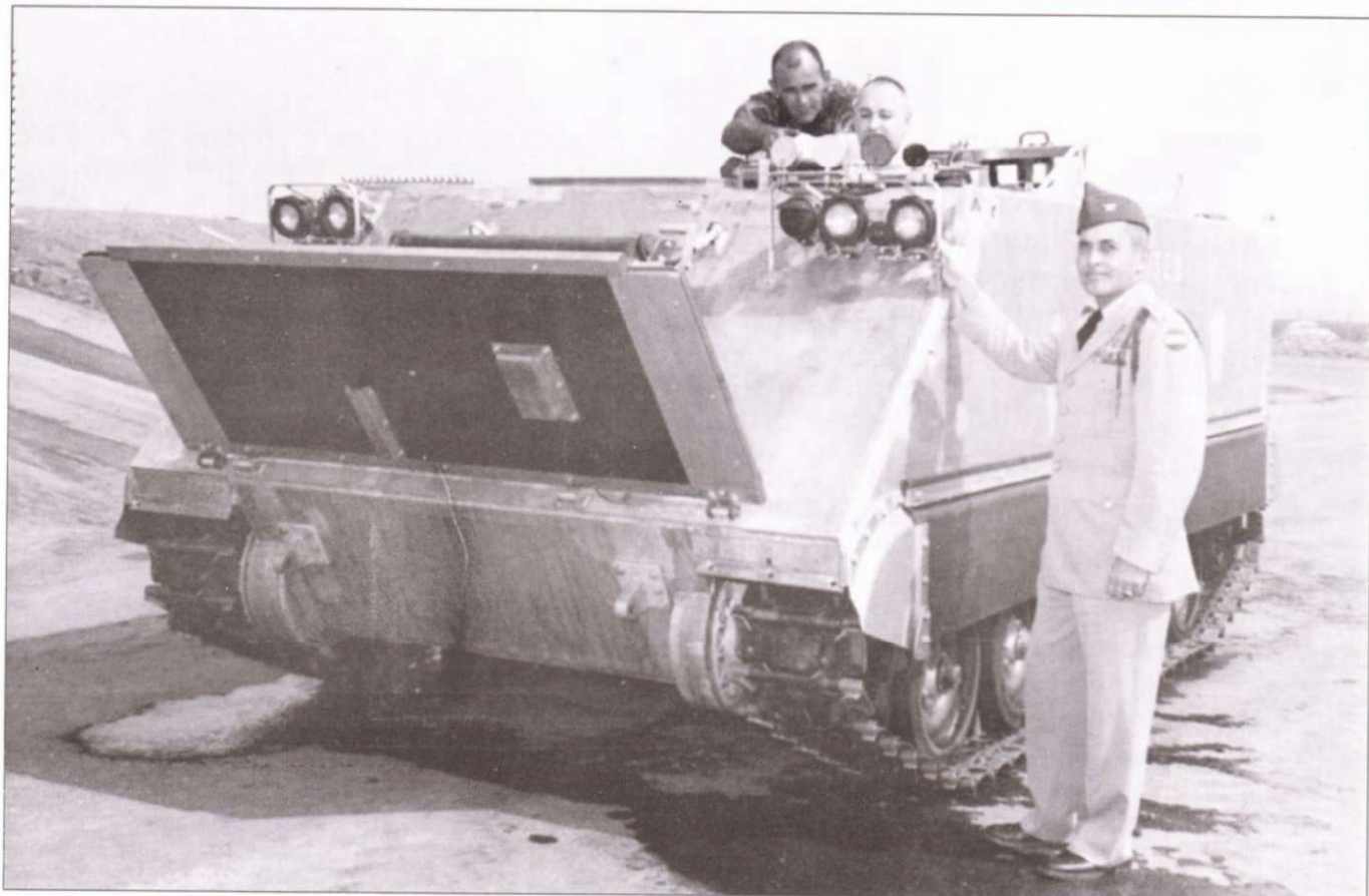
Внешне вариант Т113Е2 не отличался от предшествующей модификации Т113Е1, но вместо бензинового мотора на Т113Е2 стоял дизельный двигатель. Серийный выпуск бронетранспортеров Т113Е2 под обозначением М113А1 начался в 1964 г. Обратите внимание на некрашеный алюминиевый корпус бронетранспортера. От более ранних прототипов данный вариант отличается плоским наклонным лобовым бронелистом корпуса, без излома, и приподнятыми ленивцами.
