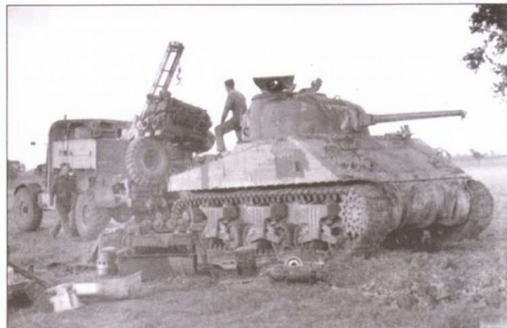
Замена двигателя на танке «Шерман III» в полевой ремонтной мастерской. Единственная видимая маркировка - номер «145437» и грузоподъемность моста. 7 ноября 1943 г.
