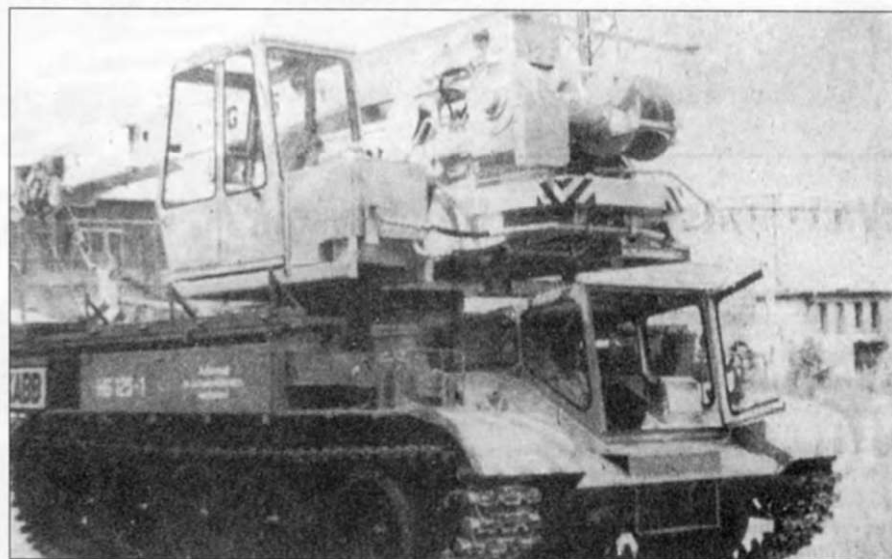
Тяжелый кран FG-125-1, переоборудованный в 1989 г. из танка Т-54 или Т-55. В краны конвертировались танки Т-54/55, попавшие под Договор о сокращении обычных вооружений в Европе.
