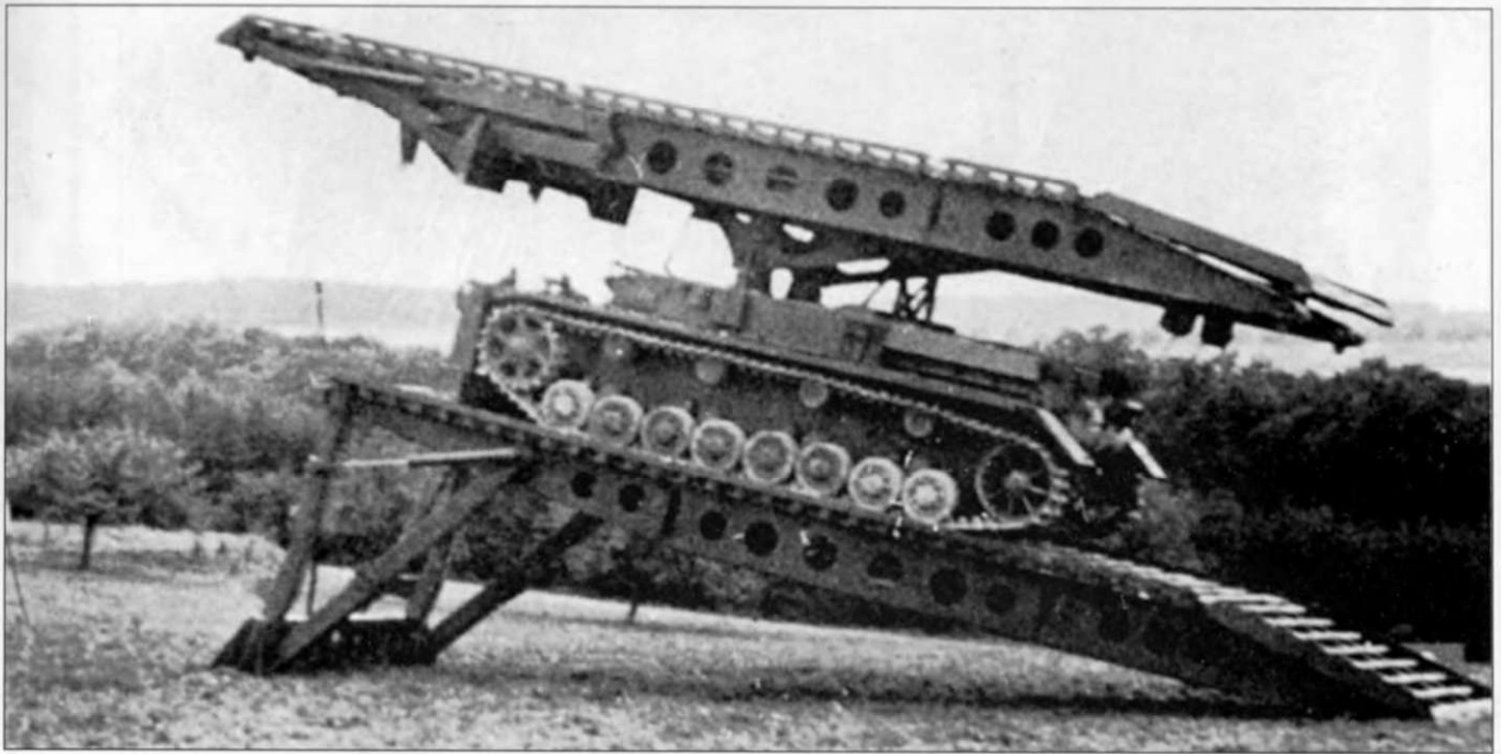
Наращивание моста: первый пролет уже уложен и на него заехал второй мостоукладчик; идет установка второго пролета.
