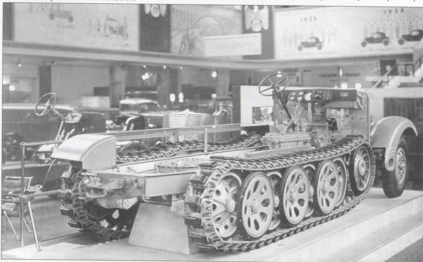
Шасси полугусеничного тягача Бюссинг-NAG BN I 7 на выставке в Берлине, 1939 г.
