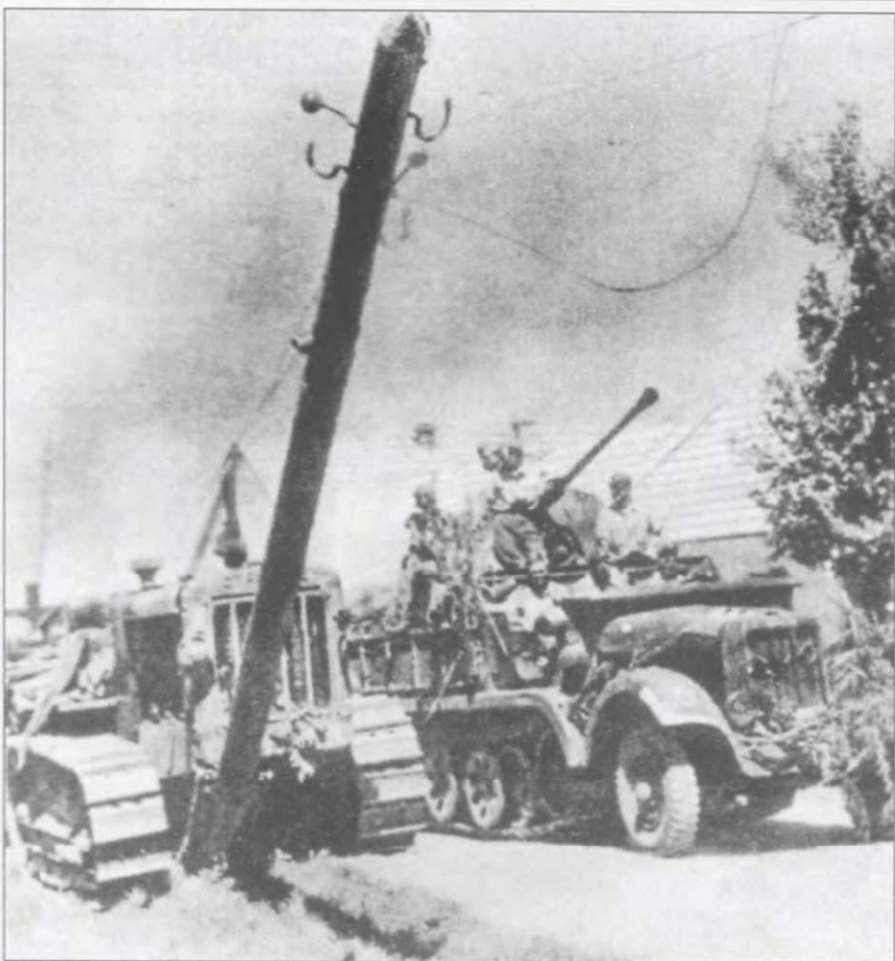
Зенитная самоходно-артиллерийская установка 3.7 см Flak-36 auf Fahrgestell mZgKw 5t Sd.Kfz. 6/2 и брошенный советский артиллерийский тягач С-65, Восточный фронт, 1942 г.
