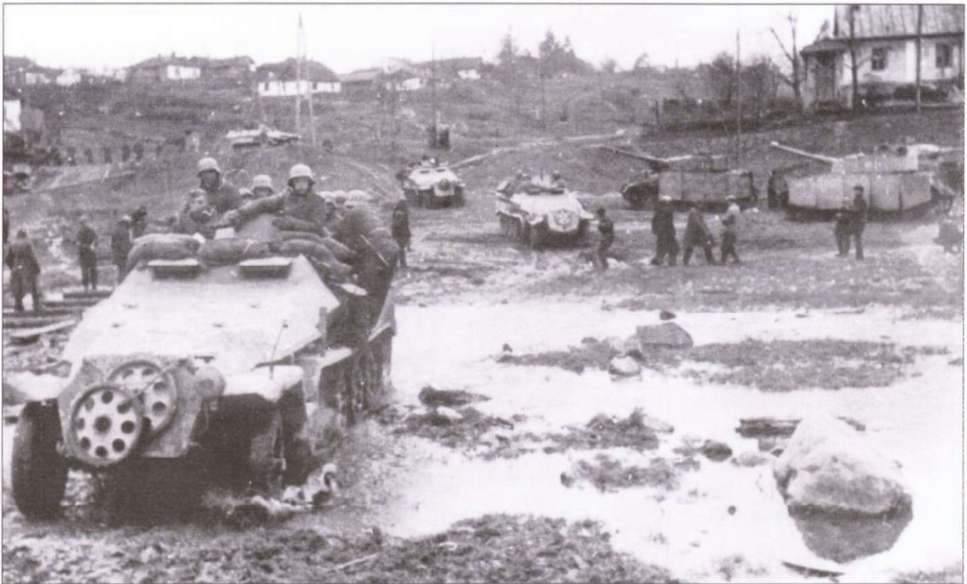
Группа бронетранспортеров Sd.Kfz. 251/1 Ausf. С из неустановленного бронеподразделения, Восточный фронт, весна 1944 г. На капотах всех машин подвешены запасные опорные катки, который используются как дополнительная защита от обстрела спереди.
