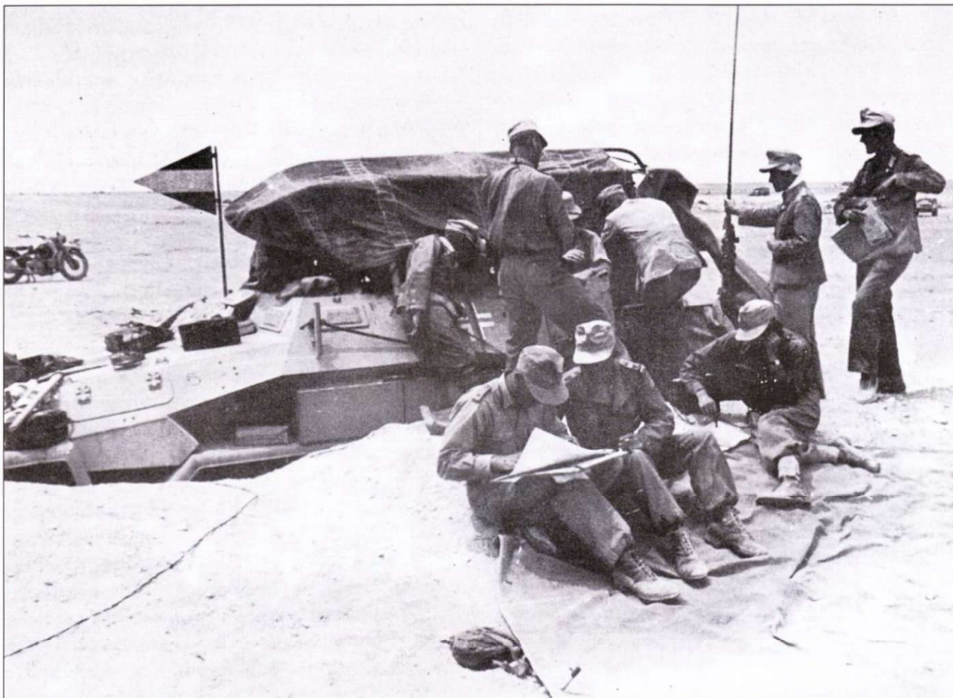
Командно-штабная машина Sd.Kfz. 251/6. Флажок черного, белого и красного цвета обозначает принадлежность машины штабу одной из дивизий корпуса Роммеля. Машина целиком окрашена в желто-коричневый цвет. Поверх рамной антенны натянут тент для защиты радиоаппаратуры и радистов от солнечных лучей. В задней части корпуса установлена дополнительная штыревая радиоантенна.
