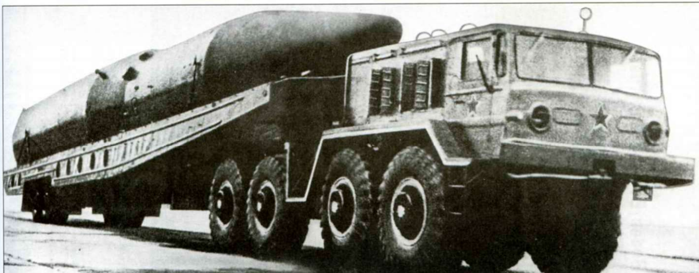
МАЗ-537 с полуприцепом еще одного варианта, на который водружена баллистическая ракета Р-9 (8К75, САСИН, SS-8).
