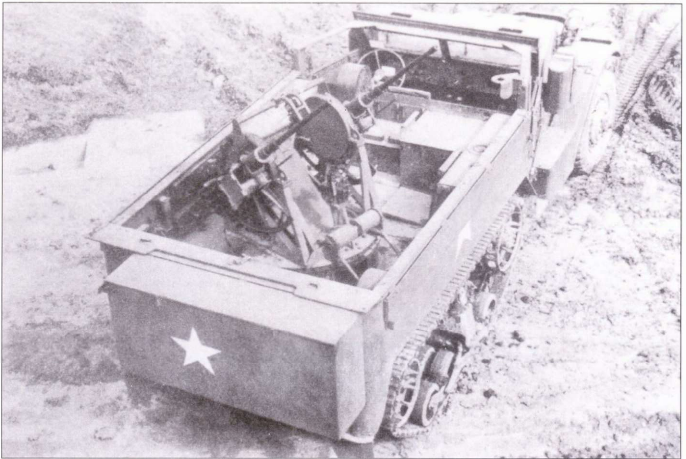
Турели Максон ставились также на бронетранспортерах М5, предназначенных для поставок по ленд-лизу, эти машины обозначались М14. Турель не комплектовалась бронещитком. Плоские крылья колес с закругленными задними концами являлись главным внешним отличием ЗСУ М14 от самоходки М13.
