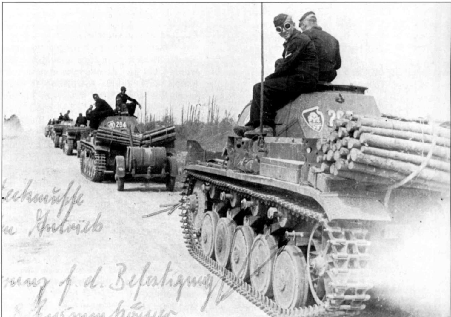
Понтонные танки PzKpfw II Ausf. C из 18-й танковой дивизии на Восточном фронте, лето 1941 г. Стрелками показаны крепления для понтонов. Обратите внимание, что все машины оснащены фашинами в виде связок дров и прицепами для двух бочек с бензином.
