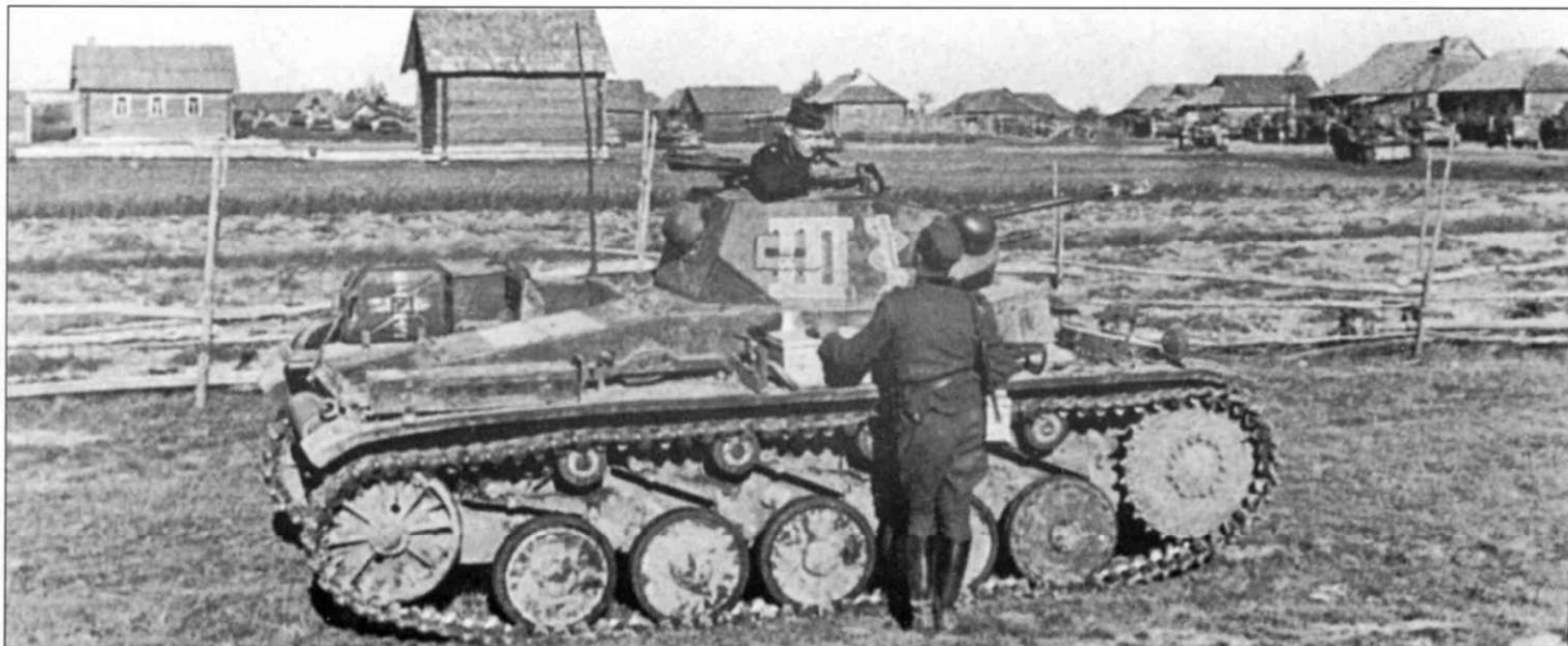
PzKpfw II Ausf. С медицинского офицера из 3-го батальона 25-го танкового полка 7-й танковой дивизии, Восточный фронт, 1941 г. На корме закреплена кнаистра с водой - одозначена белым крестом.
