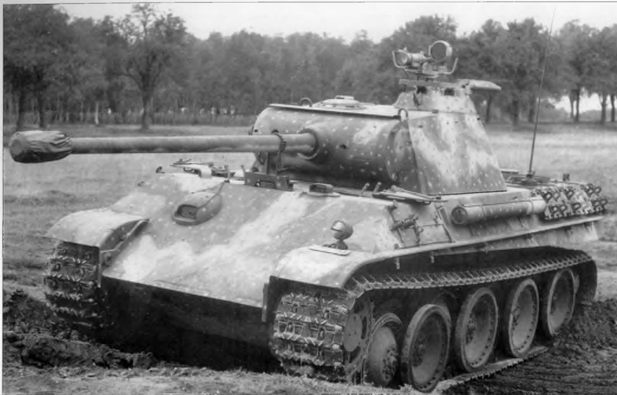
Танк «Пантера», оборудованной ИК системой F.G.1250 на командирской башенке. Машина обладает всеми отличительными признаками танка, собранного в сентябре 1944 г.: нет циммерита, нет крепления устройства Orterkompass на крыше башни, нет колпака над перископом механика-водителя, установлено ограждение сверху маски пушки, танк окрашен в засадный камуфляж.
