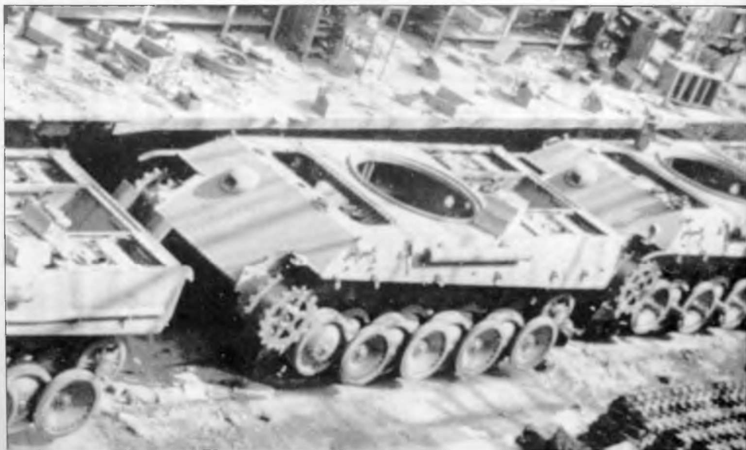
В конце войны вместо роликов на «Пантерах» сборки фирмы МНН ставились направляющие металлические желоба Gleitschuh.
