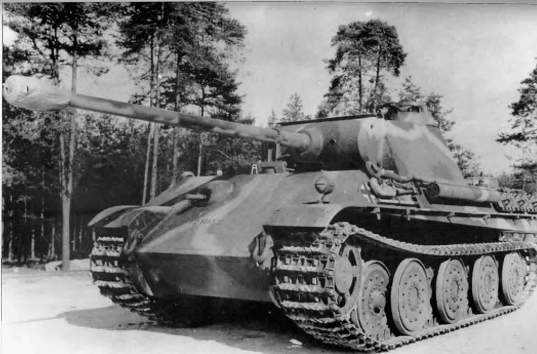
Одна из «Пантер» Ausf. G (Fgst.Nr. 121052, собранная фирмой MAN примерно 22 сентября 1944 г.) небольшой серии танков, оснащённых стальными опорными катками диаметром 800 мм с «внутренним» резиновым бандажем.
