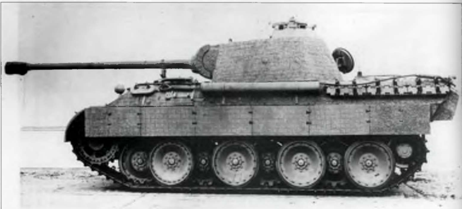
Танк «Пантера» Ausf. A сборки фирмы Даймлер-Бенц сентября - октября 1943 г. с циммеритным покрытием. В бортах башни имеются пулеметные амбразуры. Большинство опорных катков имеет по 16 болтов.
