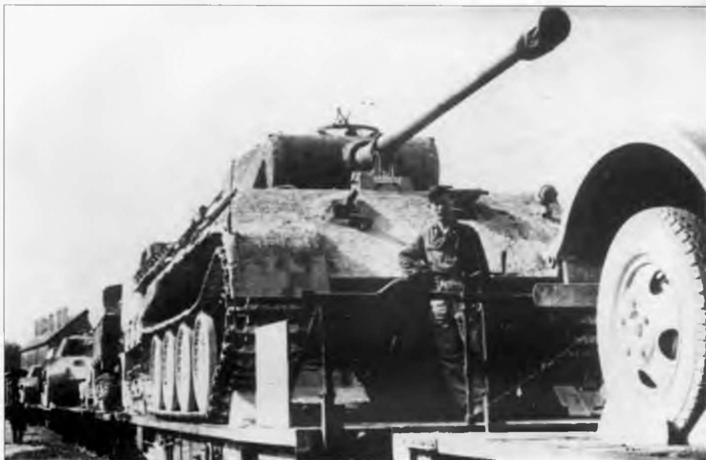
Циммерит, наносимый фирмой Даймлер-Бенц, имеет очень грубую поверхность, как у этого танка Pz.Kpfw. Panther Ausf. A (Fgst.Nr. 152372), собранного в начале марта 1944 г. Заглушка отверстия под курсовой пулемет удерживается на цепочке, которая одним концом приварена к крыше корпуса.
