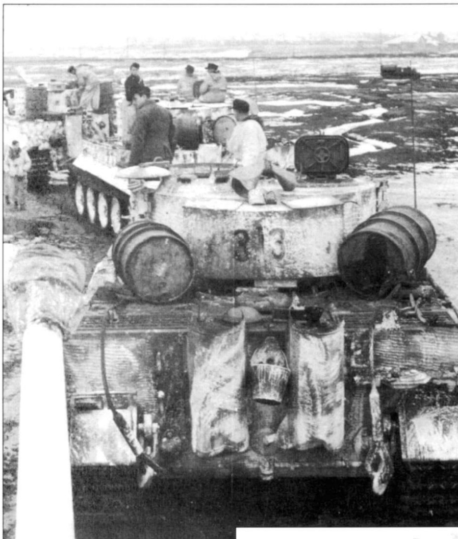
Колонна танков «тигр» из 3-й роты 502-го тяжелого танкового батальона. Дополнительные 200-литровые бочки с горючим увеличивали запас хода почти на 50 км каждая.
