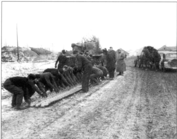
Замена гусеницы «Тигра» требовала недюженых физических усилий. Сначала гусеницы раскладывали на земле, затем загоняли на нее танк, а потом соединяли траки. На снимках - «Тигр» из 2-й роты 505-го тяжелого танкового батальона.
