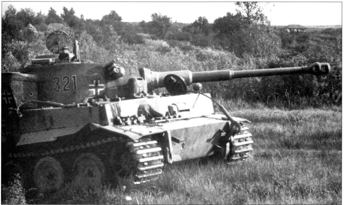
«Тигр» с бортовым номером «321», запасные траки на лобовом бронелисте отсутствуют, а крепление для них частично сорвано. В целом внешний вид танка далек от заводского, машина уже основательно потрепана. Стиль изображения цифр тактического номера характерен для всех машин батальона. В мае 1942 г. танки 1-й роты 503-го тяжелого танкового батальона имели тактические номера белого цвета, 2-й и 3-й рот - черного. В период операции «Цитадель» номера на всех танка были черного цвета с белой обводкой.
