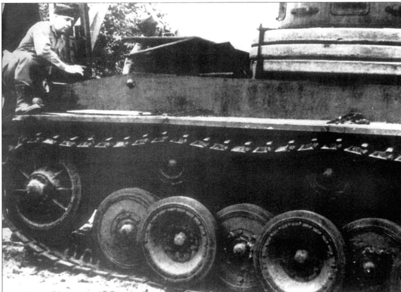
Некогда конкурировавший с машиной Порше танк VK3001 (H) достался в качестве трофея американцам. «Изюминкой» машины являлась ходовая часть с шахматным расположением семи опорных катков с каждого борта. Верхнюю ветвь гусеницы поддерживали три ролика, два из них хорошо видны на снимке. Ведущее колесо расположено впереди, ленивец сзади. Вместо башни уложены бетонные кольца - весовые имитаторы башни.
