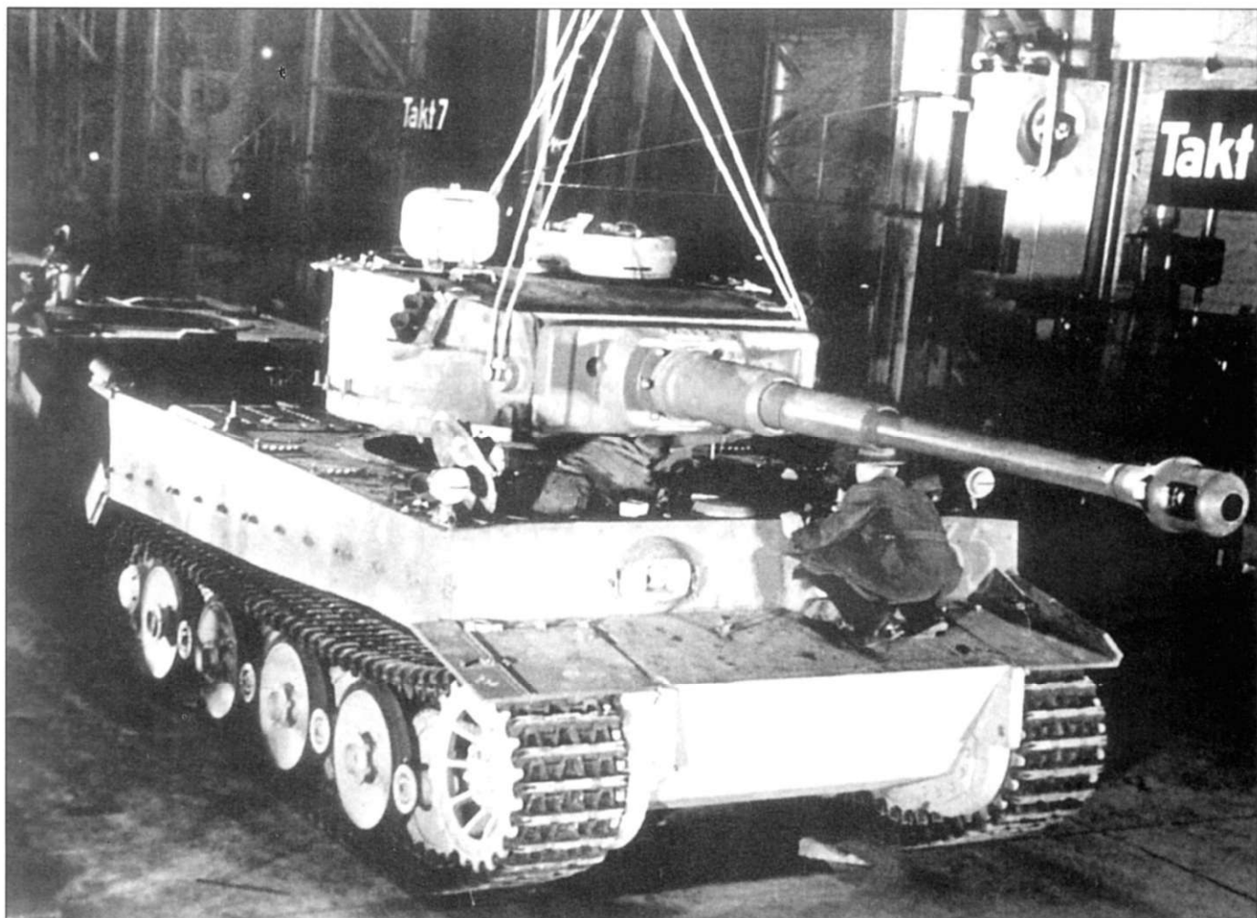
Окончательная сборка тяжелых танков «Тигр» велась на заводе фирмы Вегманн. Данный снимок сделан в 1943 г. Корпус и башня полностью окрашены в темно-желтый цвет. Обратите внимание на снятый внешний ряд опорных катков и узкие транспортные гусеницы. Башни с серийными номерами с 184 по 286 оснащались дымовыми гранатометами и не имели эшпоров заряжающего. На снимке - одна из этих башен.
