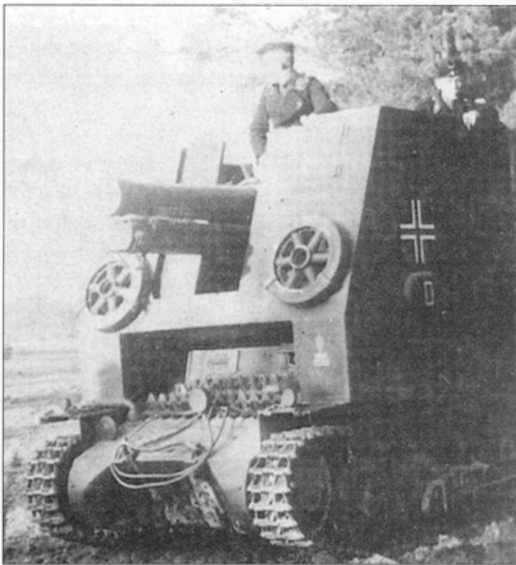
Самоходка «D» из s.I.G.Kp. (mot.S.) 701, начало кампании на Восточном фронте. В левой лобовой части рубки нанесена тактическая маркировка, ниже символики 9-й панцердивизии. Типично для машин этой роты периода начала операции «Барбаросса» крепление запасных опорных катков.
