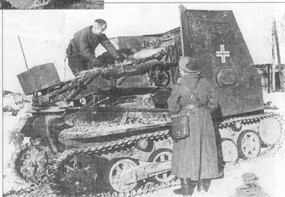
Та же машина, те же солдаты. На левом заднем подкрылке нарисован крест. Самоходка оснащена радиостанцией. По бортам моторного отделения приварены усиливающие конструкцию железяки.
