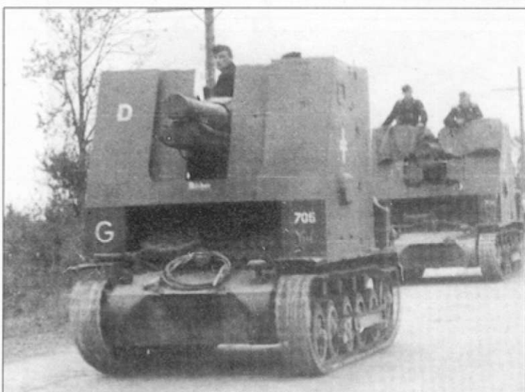
Самоходка «D» из s.I.G.Кр. (mot.S.) 706, за ней следует еще одна боевая машина, ранняя стадия операции «Барбаросса». Маркировка обычна для машин 706-й роты. Фара Нотек установлена на бронекорпусе.
