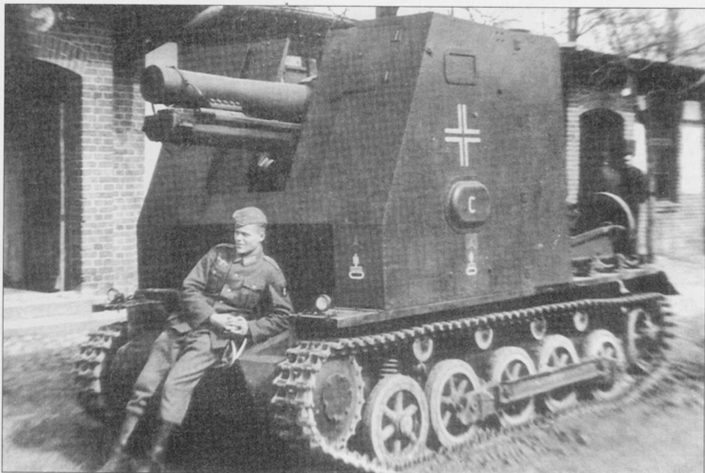
Самоходка «С» из s.I.G.Kp. (mot.S.) 702. На крыше моторного отделения, в задней части установлен запасной опорный каток. Машина промаркирована сразу двумя эмблемами 1-й танковой дивизии, использовавшимися весной 1941 г. – звезда Мерседес и крестик. Характерное расположение запасного опорного катка типично для машин 702-й роты. Фара Нотек пока еще не установлена.
