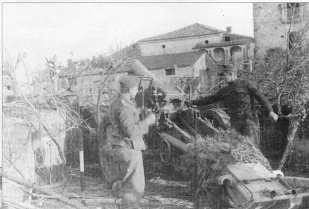
Гаубица на улице населенного пункта где-то в Южной Европе. Защитой от осколков служат винные корзины, заполненные землей.
