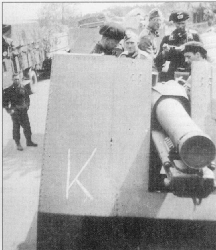
Изменение группы армий для s.I.G.Кр. (mot.S.) 702. Литера «К» написана т руки мелом. На снимке хорошо видны головки заклепок на рубке.
