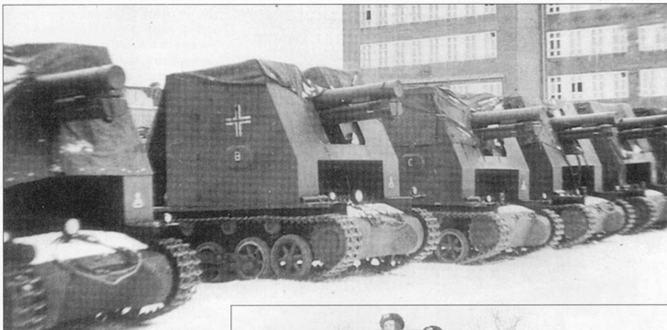
Самоходно-артиллерийских установки из s.I.G.Kp. (mot.S.) 702, зима 1940 – 1941 г.г. Рубки закрыты сверху тентами.
