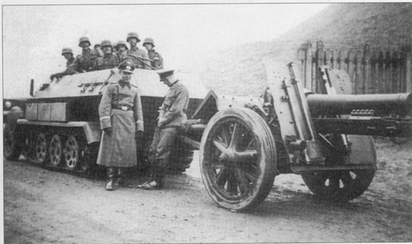
Полугусеничный бронетранспортер Sd.Kfz. 251 Ausf. A с гаубицей 15 см s.I.G. 33 (mot.) на прицепе. Вероятно, бронетранспортер представляет собой модификацию 251/4, оптимизированную для буксировки s.I.G. Такие машины применялись также для буксировки орудий 7.5 см I.I.G.
