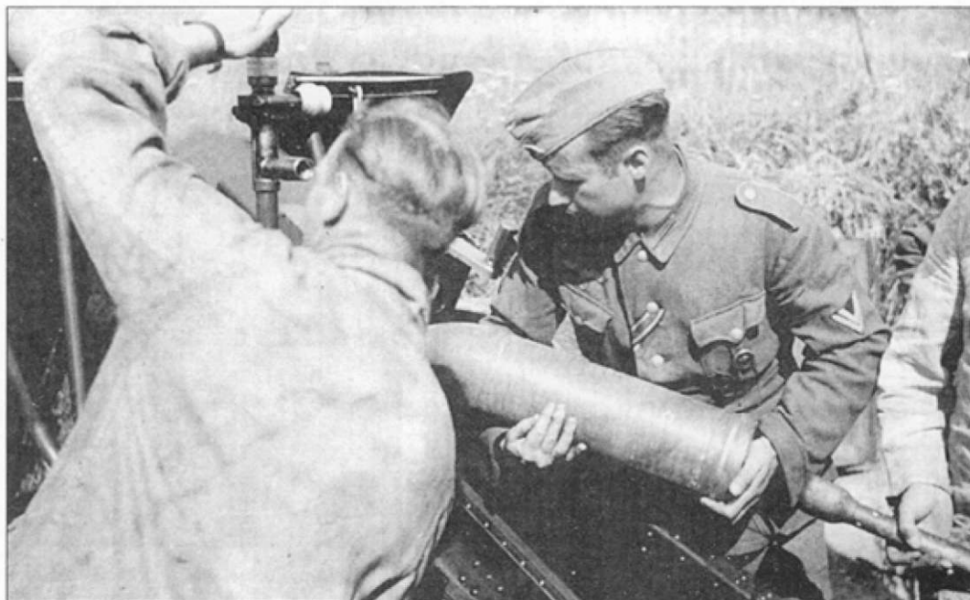
Заряжение гаубицы. Заряжающий может легко травмировать левую руку. Наводчик прицеливается через панорамный прицел № 32, установленный на адаптере.
