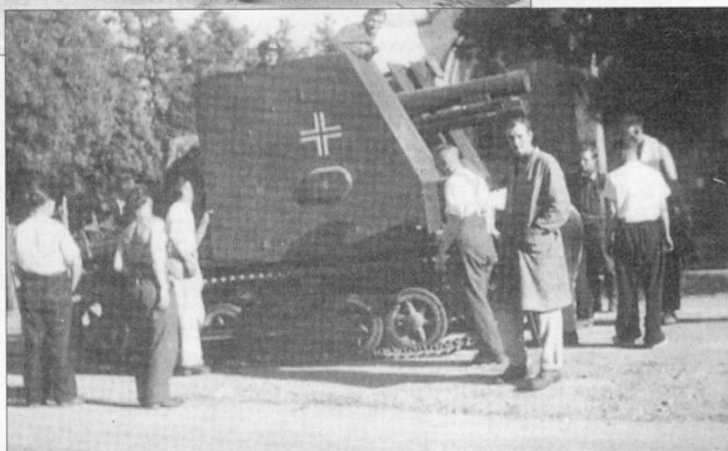
Самоходка «F» из s.I.G.Kp. (mot.S.) 705, имя на броне пока не написано. Веро- ятно машина получила повреждения в самом на- чале французской кампа- нии. Передний опорный каток правого борта ут- рачен – типичный факт для перегруженного шас- си. Для отправки в тыл на ремонт машину погрузи- ли на транспортер Sd.Anh.115. На корме са- моходки установлена ра- диоантенна. 705-я рота стала одним из немногих подразделений вермахта, боевая техника которой в период кампании во Фран- ции была полностью ра- диофицирована.
