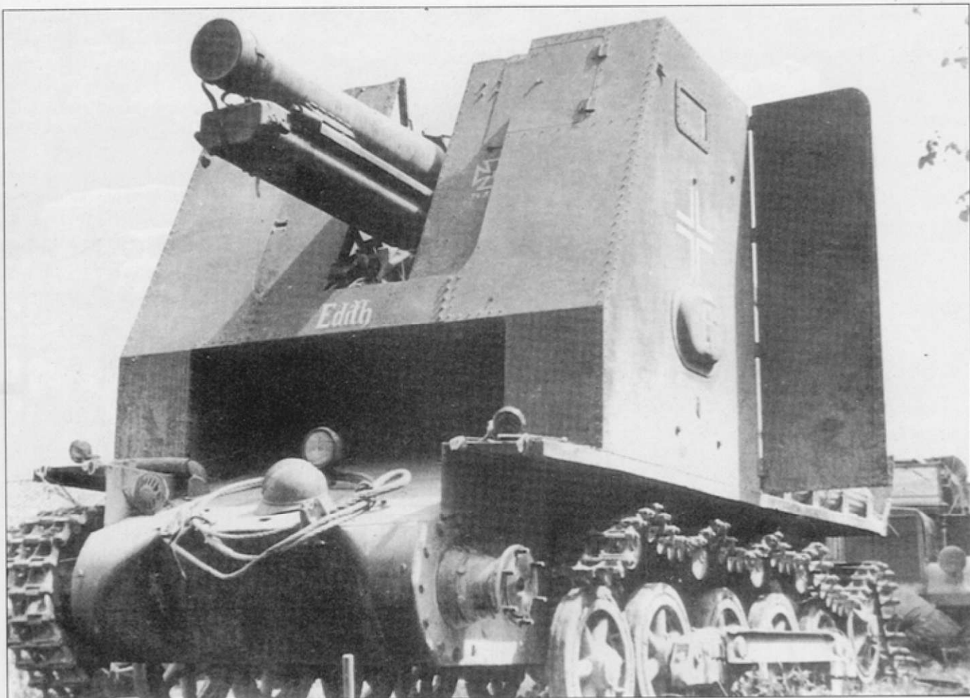
Самоходка «Edith». На орудийном щите нарисован крест и дата гибели, 29 мая 1940 г., одного из членов экипажа. Левое ведущее колесо снято. Демонтированы оба передних подкрылка. Под подкрылки набивалось много грязи.
