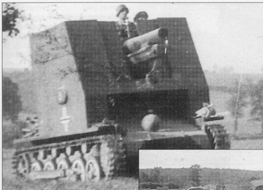
Самоходка «В» («Berta»?) из s.I.G.Кр. (mot.S.) 701. Принадлежность машине к 701-й роте легко установить по кресту, нарисованному ниже колпака оси гаубицы. Снимок выполнен летом 1940 г., после завершения боев во Франции. Интересный момент – на левое крыло поставлена модель гаубицы. На войне такими пустяками заниматься некогда.
