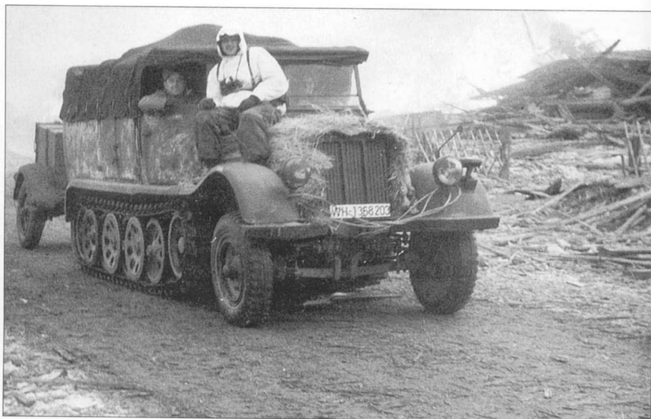
Тягач SdKfz 11 зимой 1941-42 годов. Видна слабая подготовка немецкой армии к войне зимой. Капот тягача утеплен при помощи соломы. Машина замаскирована почти стершейся белой краской.
