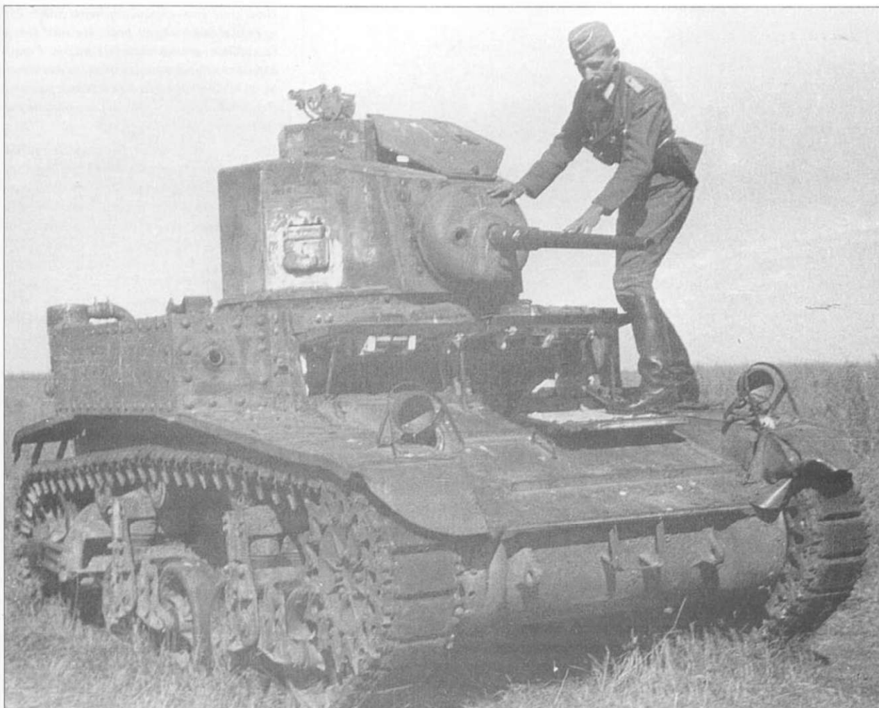
Количество американских танков на Южном фронте постоянно возрастало, из-за поставок через Иран. На снимке брошенный М3 «Генерал Стюарт», достаточно раннего выпуска. При покидании танка с него сняты все пулеметы «Браунинг» М1919. Обратите внимание, слева в бортовом скосе вовсе не пробоина от снаряда, а отверстие для ствола пулемета, установленного в корпусе.
