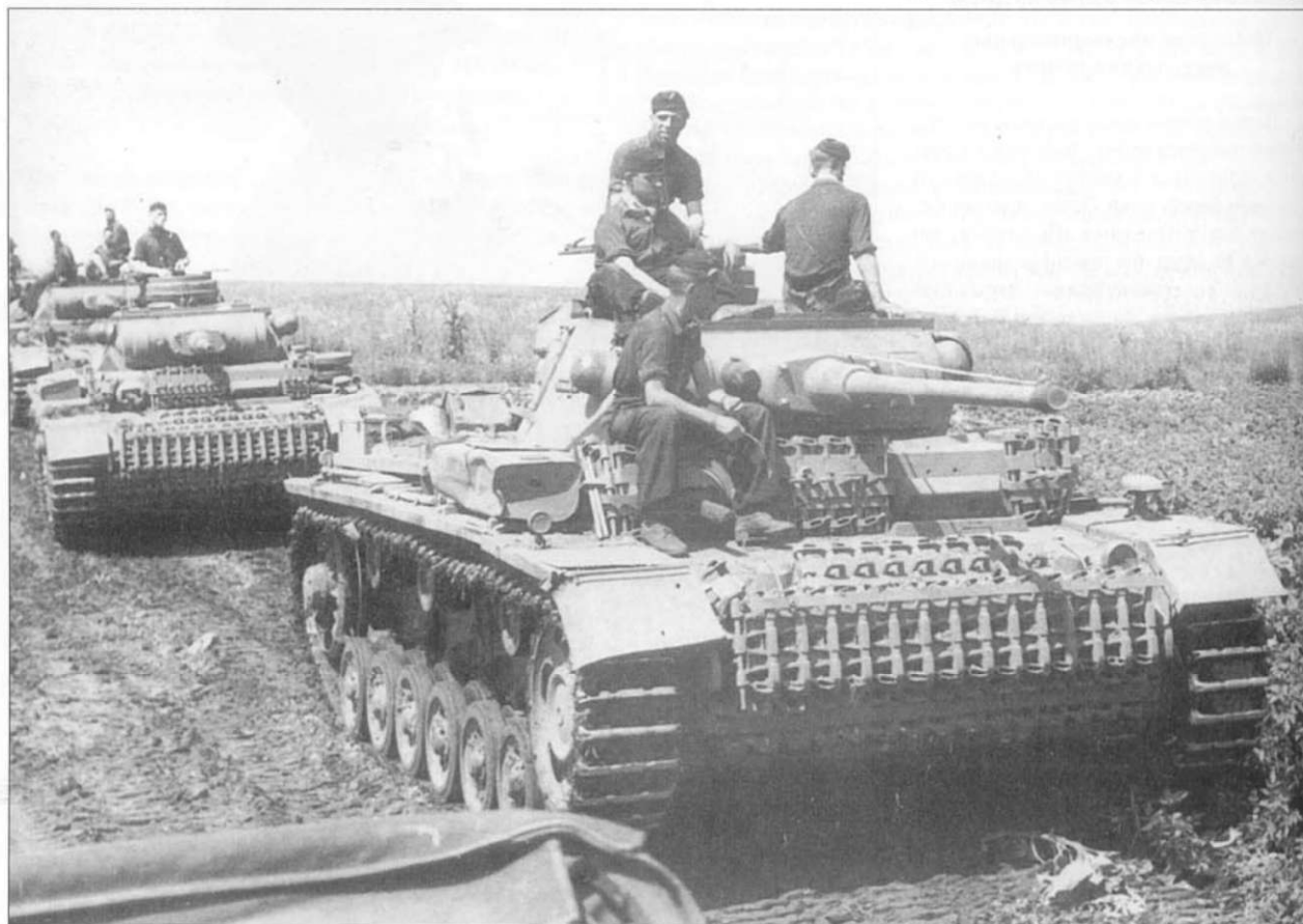
Колонна новых Pz III накануне наступления на юге России. Pz III J получили новую пушку калибра 50 мм и длиной ствола 60 калибров. Это позволило им успешно бороться с русскими танками. Однако толщина брони оставалась маленькой и экипажи как могли, усиливали ее траками гусениц. На передней части крыла танка видна Эйфелева башня – знак 23-й танковой дивизии.
