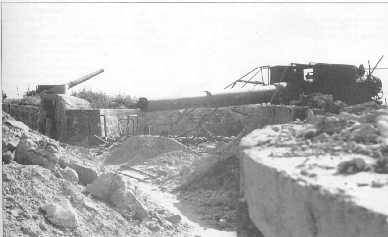
Захваченная немцами советская береговая батарея номер 10, расположенная южнее деревни Мамашай, недалеко от Севастополя. Батарея располагала четырьмя 203-мм пушками типа «Канэ». Пушки установлены открыто и не имеют больших щитов.
