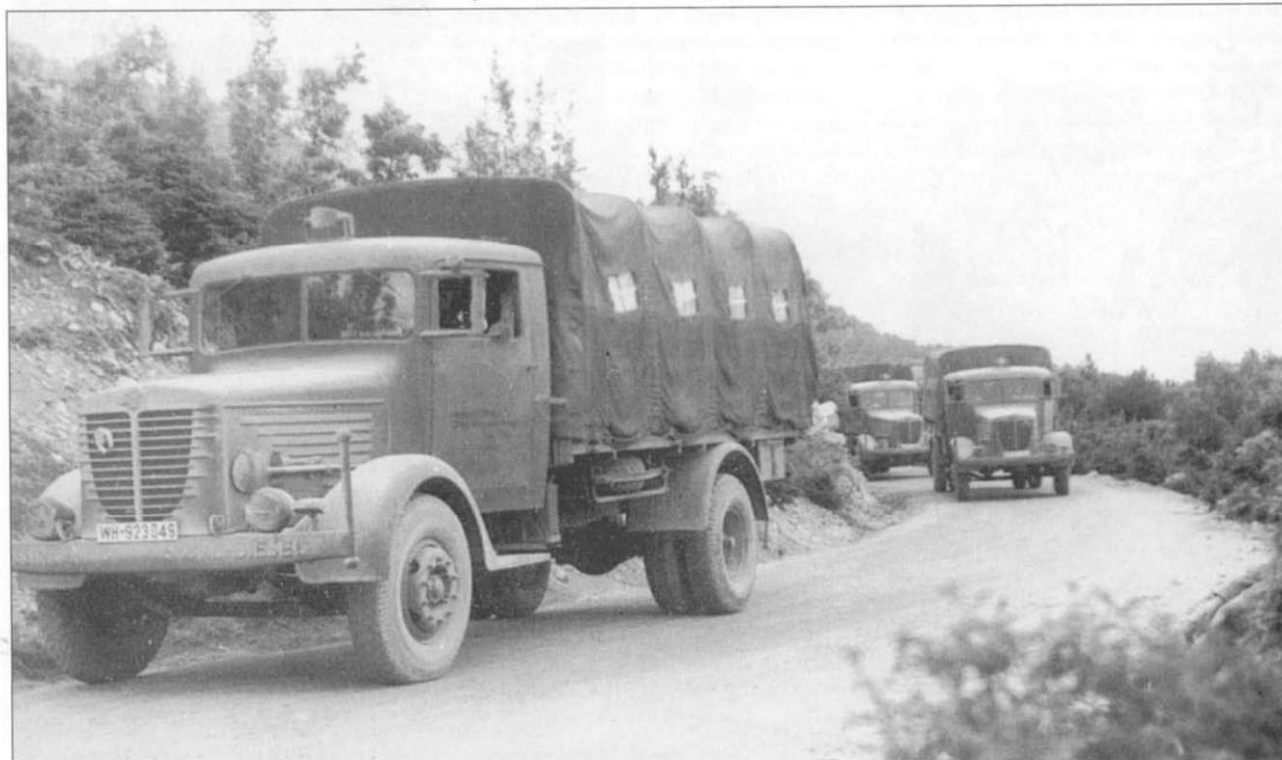
Колонна грузовиков «Бюссинг-Наг» в Крыму. У переднего грузовика видна марка, выштампованная на капоте. По ней можно определить, что машина имеет 6-цилиндровый дизельный двигатель. По армейской классификации эти машины назывались 4 x 2, Lkw 4,5 тонн Typ 500 S.
