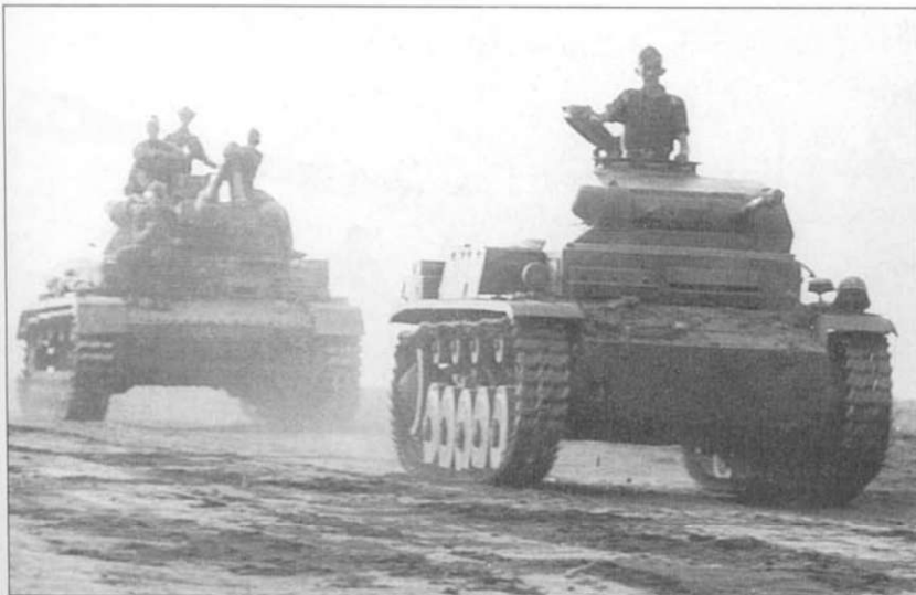
За Pz II движется Pz IV F2, вооруженный новой длинноствольной 75 мм пушкой, способной поражать все советские танки.
