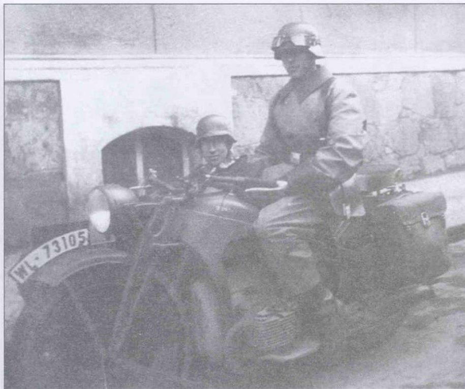
Тяжелый Zündapp K800W с тропическими кожаными седельными сумками. Даже с коляской из-за узких шин эта машина была весьма неустойчива на бездорожье.
