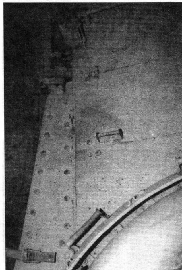
Вид сверху на левую часть крыши передней части корпуса. Триест.
