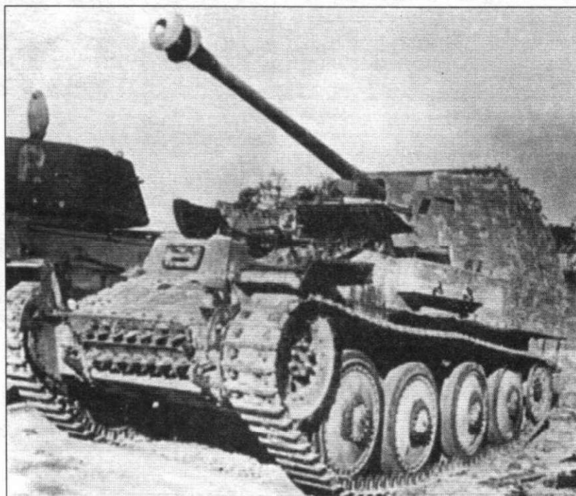
Истребитель танков «Мардер III» Ausf. M позднего выпуска. Снимок сделан на выставке трофейной техники в Москве. Возможно это вообще единственный «Мардер», который был покрыт циммеритной обмазкой.
