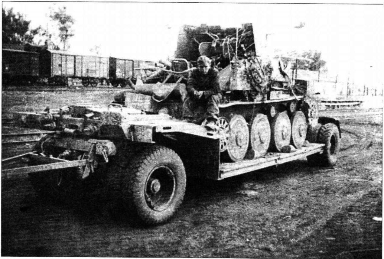
Редкий снимок самоходки Sd.Kfz. 139 со снятой гусеницей. Машина погружена на транспортер Sd.Afh. 115. Под опорные катки истребителя танков засунуты импровизированные колодки, сделанные из бревна.
