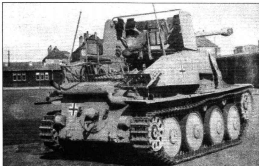
Истребитель танков «Мардер III» из Pz.Jg.Ers.Abt. 4. Машина целиком окрашена в темно-желтый цвет. Обратите внимание на отсутствие запасных гусеничных траков на лобовой детали корпуса.
