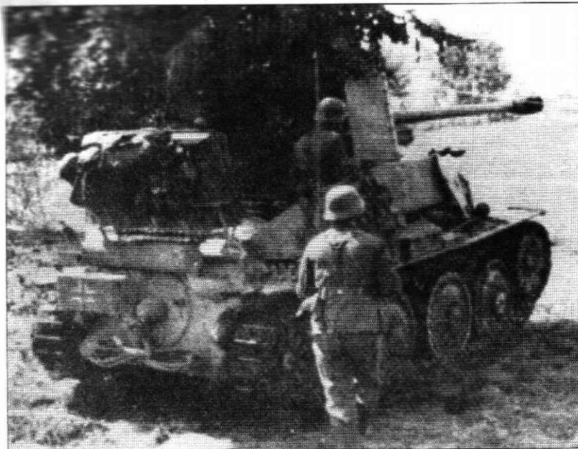
Типичная огневая позиция истребителя танков «Мардер III». Самоходка укрыта деревом. Крест нанесен на кожух дымовых гранатометов. Обратите внимание на большой ящик-контейнер, закрепленный на корме боевого отделения.
