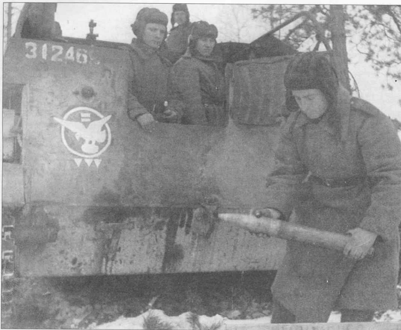
Вид сзади на самоходно-артиллерийскую установку СУ-76, хорошо видна необычная для техники Красной Армии полковая эмблема. Две полосы и три треугольника - вероятно обозначают номер батареи и дивизиона в полку. Выше написан шестизначный заводской номер, что также является редкостью для советской бронетехники.
