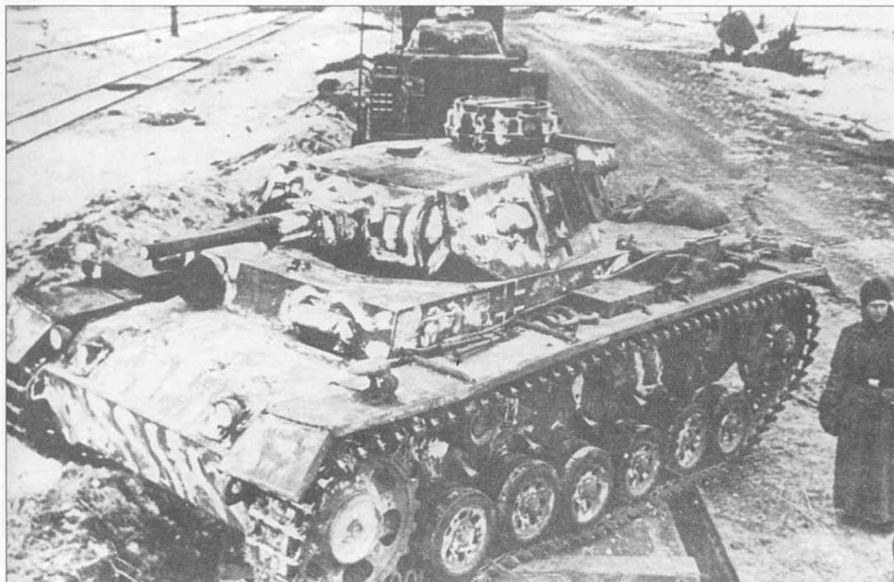
Солдаты Красной Армии осматривают эшелон с незгруженной немецкой военной техникой, 4 декабря 1942 г. На платформе стоят танки Pz.Kpfw. III Ausf. H. Снимок дает представление о временной зимней окраске танков вермахта. Белая краска небрежна нанесена на броню, незаметно даже попыток окрасить всю машину целиком.
