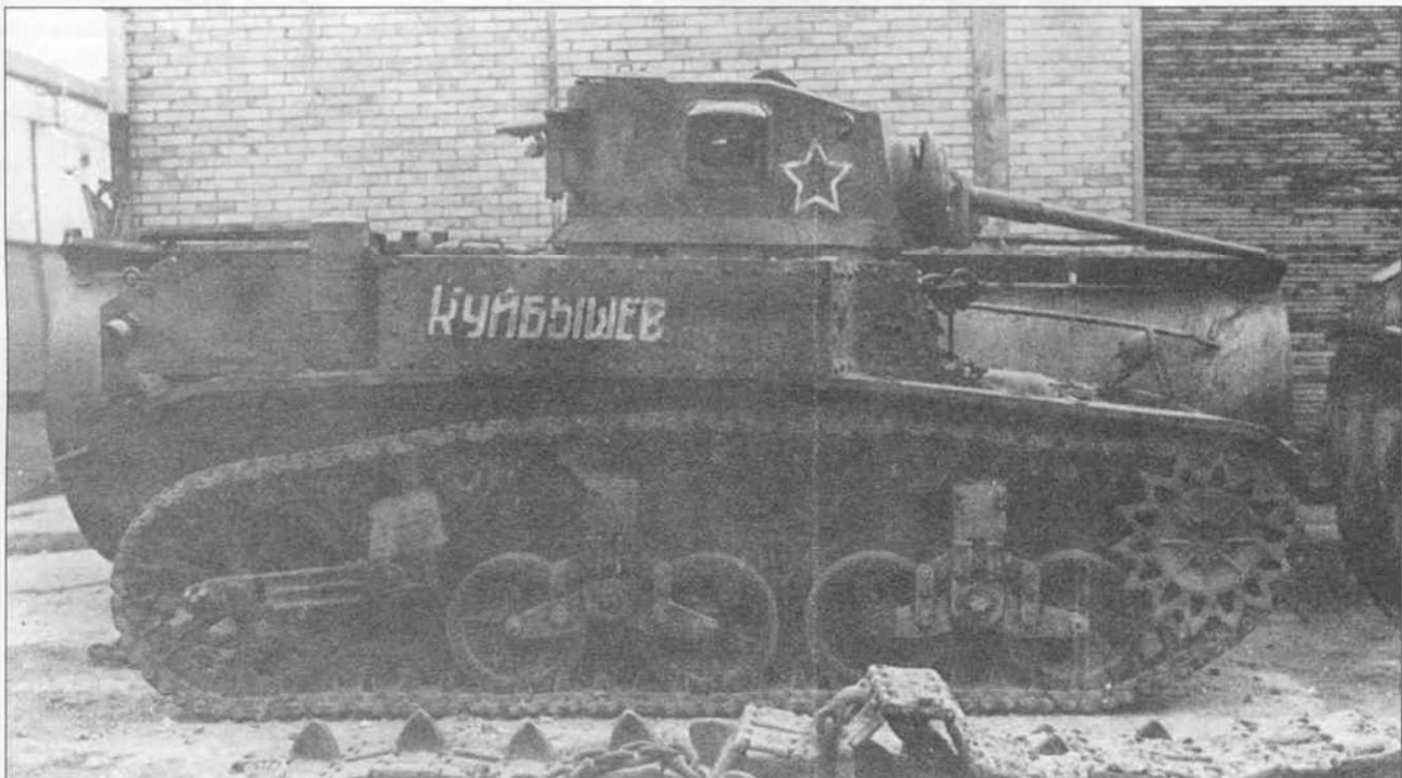
Дизельный танк М3А1, названный в честь города Куйбышев (или в честь революционного деятеля?). Пятиконечные звезды редко изображались на броне советских танков, однако на башине «Стюарта» звезда есть. На борту корпуса можно различить американский серийный номер W. 307216.
