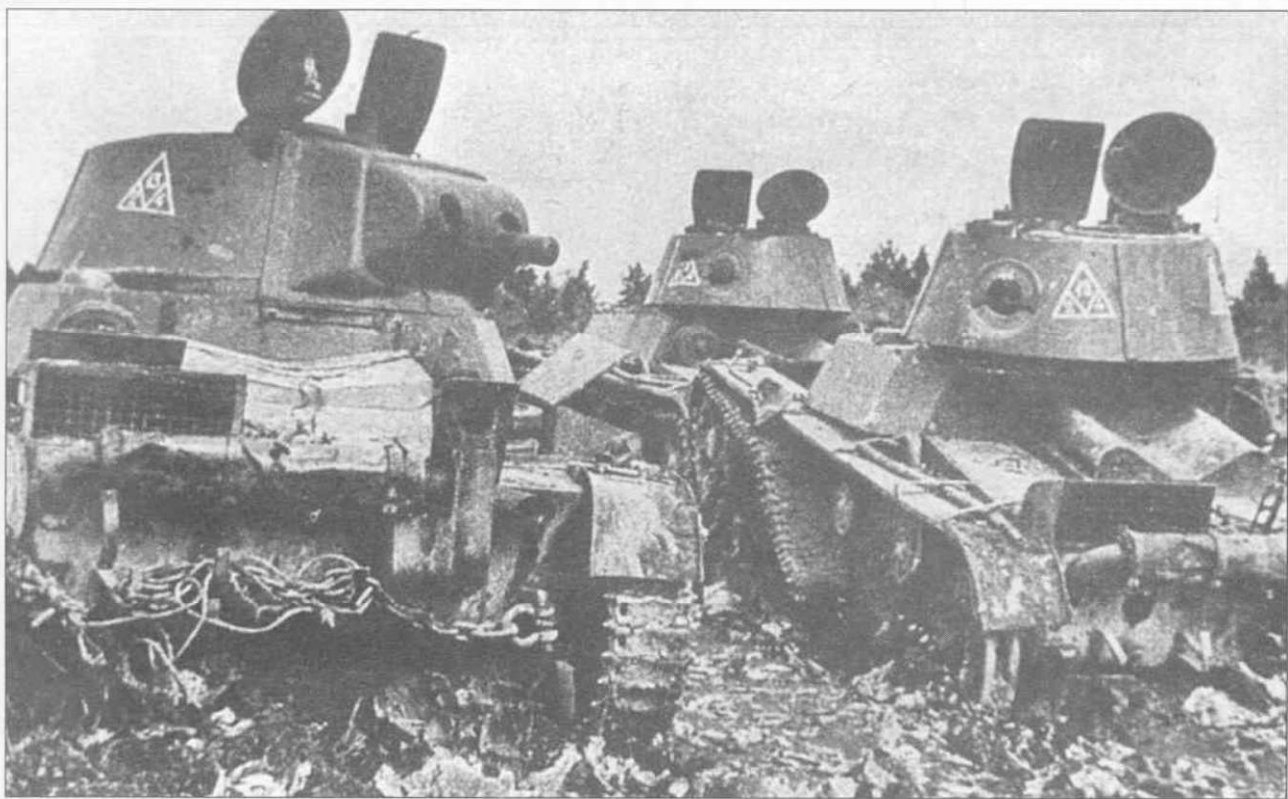
Взвод брошенных огнеметных танков ОТ-133. На башнях хорошо видны тактические знаки в виде треугольников. Двухзначные номера («13» на левом танке, «12» - на правом) скорее всего - являются номерами самих танков, цифры 2 и 4 - номер батальона и роты.
