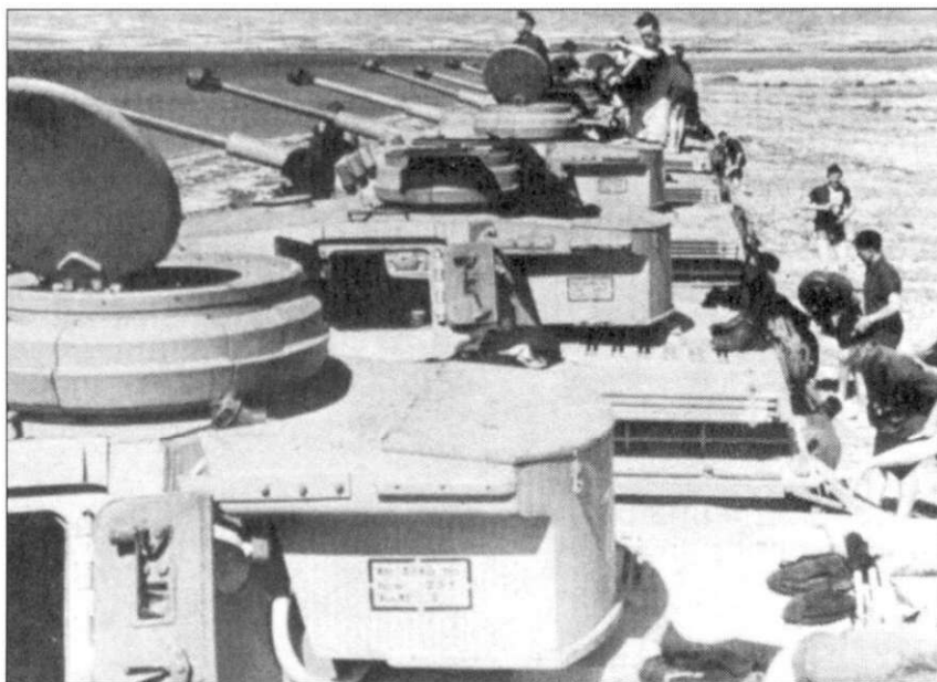
Строй средних танков PzKpfw IVs Ausf G сфотографирован в Греции в 1943 году. На башнях хорошо видны стандартные грузовые марки, используемые для таких машин. В грузовой марке приведены следующие данные: служебный номер (SdKfz 161), вес брутто (23t) и железнодорожный погрузочный класс (S).
