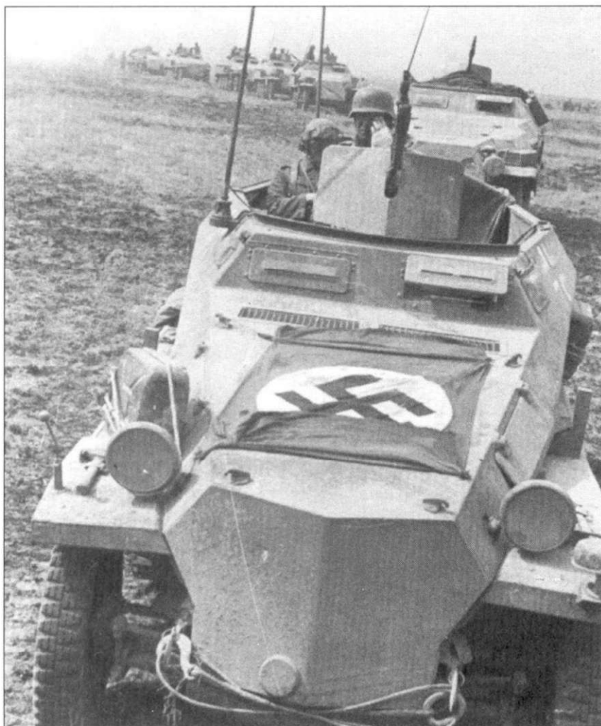
Полугусеничные бронетранспортеры, сфотографированные летом 1942 г., окрашены в темно-серый цвет, однако из-за того, что они сильно забрызганы грязью и покрыты пылью, их первоначальный серый цвет почти полностью скрыт. Передний бронетранспортер это машина связи- SdKfz 251/3.
