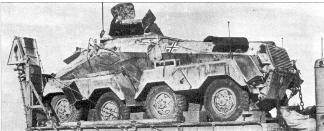
Поврежденная внутренним пожаром и захваченная союзниками тяжелая бронемашина SdKfz 321 (8-Rad), демонстрирует сильно испорченную камуфляжную окраску. Обратите внимание на пятна от масла и смазки и на обизвествление красочного покрытия.
