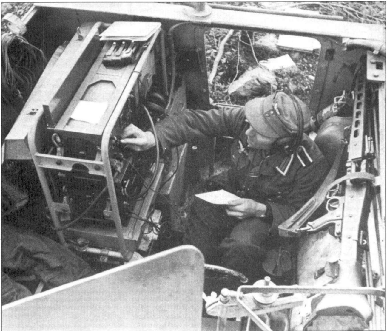
Здесь мы видим машину связи - бронетранспортер SdKfz 250/3. Темно-желтая краска, которой окрашены ее внешние поверхности использована и как основной цвет для окраски интерьера. Многие мелкие детали интерьера и кронштейны так же базового цвета. Надписи нанесены черным. Радиостанция и ее стойка окрашены полевым серым и черным..
