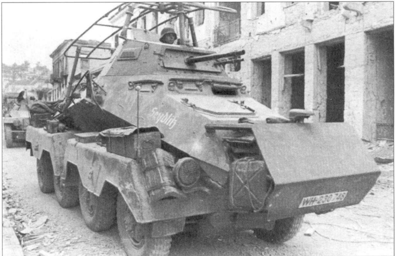
Восьмиколесный тяжелый броневедомитель SdKfz 232 сфотографирован во время оккупации Балкан. Машина полностью окрашена в темно-желтый цвет и покрыта слоем пыли. Надпись «Seydlitz» - белая. Обратите внимание на канистры, укрепленные позади переднего броневых листа.
