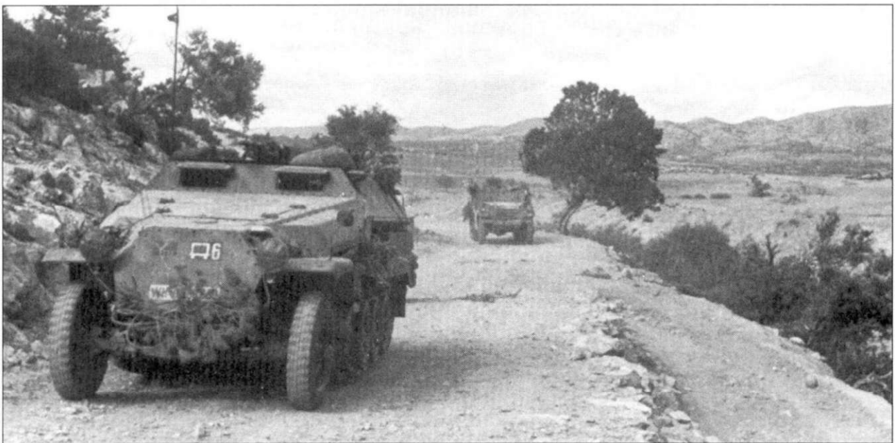
Бронетранспортер SdKfz 251/1 Ausf C на переднем плане и захваченный американский полугусеничный бронетранспортер M3, сфотографированные на дороге в Тунисе. Этот SdKfz 251 из 10-й танковой дивизии покрашен распылителем в темно-желтый цвет поверх первоначальной темно-серой окраски. Оознавательные знаки оставлены незакрашенными, как это обычно делалось в начале Африканской кампании.
