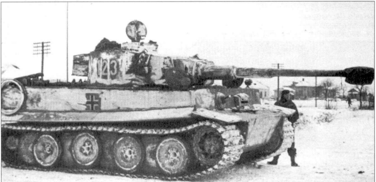
Тяжелый танк Тигр I неподалеку от Ленинграда зимой 1942 г. Темно-серый базовый цвет покрыт белым, который наложен грубыми мазками на башне и более аккуратно на корпусе. Старые опознавательные знаки остались не закрашенными, это была обычная практика.
