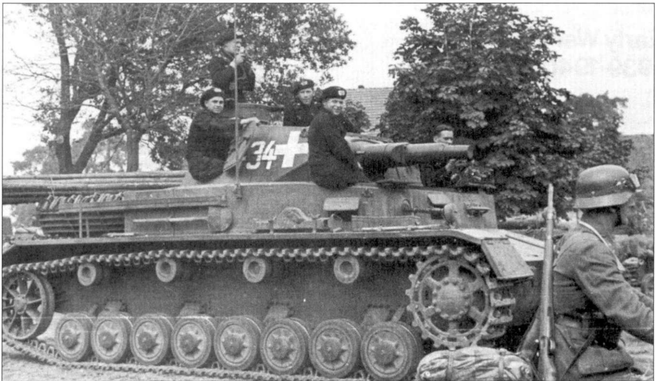
Сфотографированный в Польше средний танк PzKpfw IV Ausf A окрашен полностью в темно-серый цвет, такая окраска использовалась на большинстве немецкой бронетехники в тот период. Номер на башне и крест - белые. Обратите внимание на свежесрезанный шесты, уложенные на задней части корпуса.
