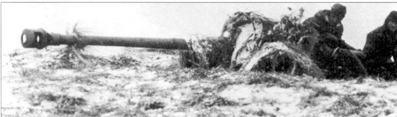
Расчет этого 75-мм противотанкового орудия РАК 40 воспользовался «естественным» камуфляжем. Трава и солома укрепленные на орудии покрыты выпавшим позднее снегом. Это сочетание весьма удачно маскирует его в данном месте. Орудие максимально врыто в землю, чтобы его силуэт был как можно ниже.
