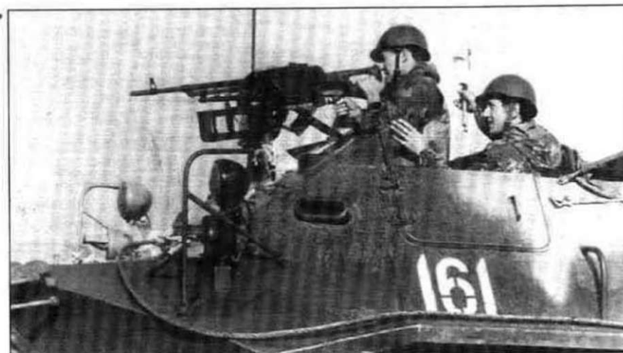
БТР-60П недолго находился на вооружении армейских подразделений «первого эшелона», гораздо дольше он продержался в морской пехоте. Этот БТР-60П морской пехоты, сфотографированный во время учений «ЮГ» в июле 1971 года, вооружен более современным 7,62-мм пулеметом ПКМ. Ограждение фар как на более позднем БТР-60ПА.
