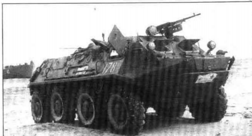
БТР-60П недолго находился на вооружении армейских подразделений «первого эшелона», гораздо дольше он продержался в морской пехоте. Этот БТР-60П морской пехоты, сфотографированный во время учений «ЮГ» в июле 1971 года, вооружен более современным 7,62-мм пулеметом ПКМ. Ограждение фар как на более позднем БТР-60ПА.
