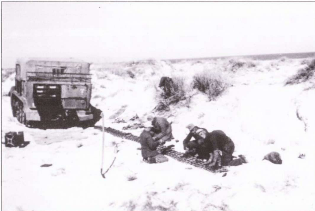
Ремонт гусеницы с использованием инструментов и запчастей, имевшихся на борту тягача. Команда могла справляться самостоятельно с такими неприятностями.
