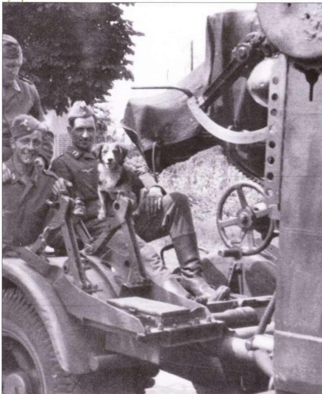
Артиллеристы позируют фотографу со сверхтитаным членом расчета – щенком собаки породы дворняга. На переднем плане – рама для крепления барабана под электрокабель. Оба передка транспорта были снабжены пневматическими тормозами, которые запитывались сжатым воздухом от тягача, но активизировались тормозистом с помощью специального рычага.
