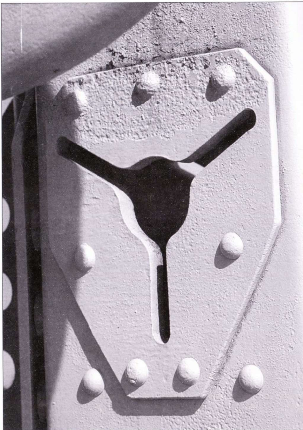
Усиливающая пластина в месте фиксации цепи.
