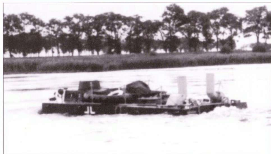
2-й прототип амфибии LWS II на испытаниях, машина сидит в воде очень низко.
