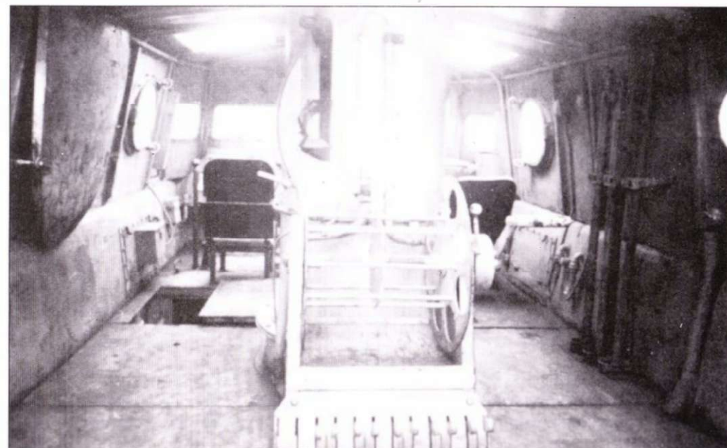
Интерьер рубки, вид от кормы. В передней части находятся места механика-водителя, радиста и командира. На переднем плане - вентиляционная шахта, перед шахтой - ручная лебедка, ниже лебедки - рычаги регулировки топливной и воздушной систем.
