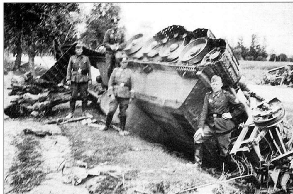
Т-34 первых производственных серий, опрокинутый в кювет близким разрывом авиабомбы. И снова, полностью выгоревшие бандажи при отсутствии копоти на броне.
