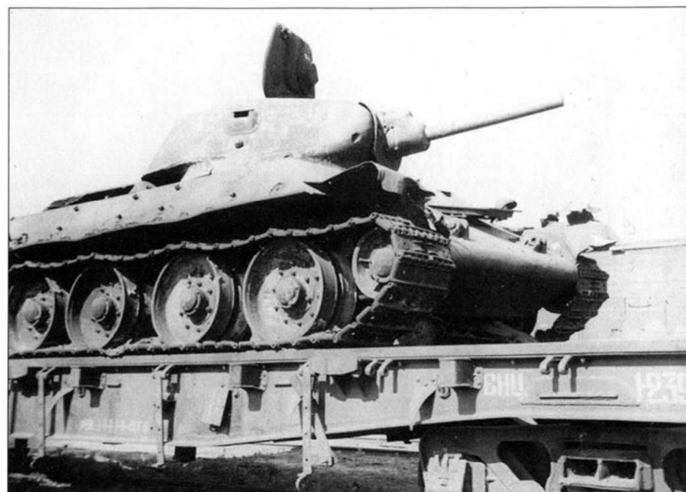
Серия снимков подбитых Т-34 выпуска 1940 года с литой башней. Танки горели - на ободах колес нет резинового бандажа. Экипажи не успели освоить новые танки, поэтому часто их бросали из-за механических поломок, вызванных неопытностью механиков-водителей.
