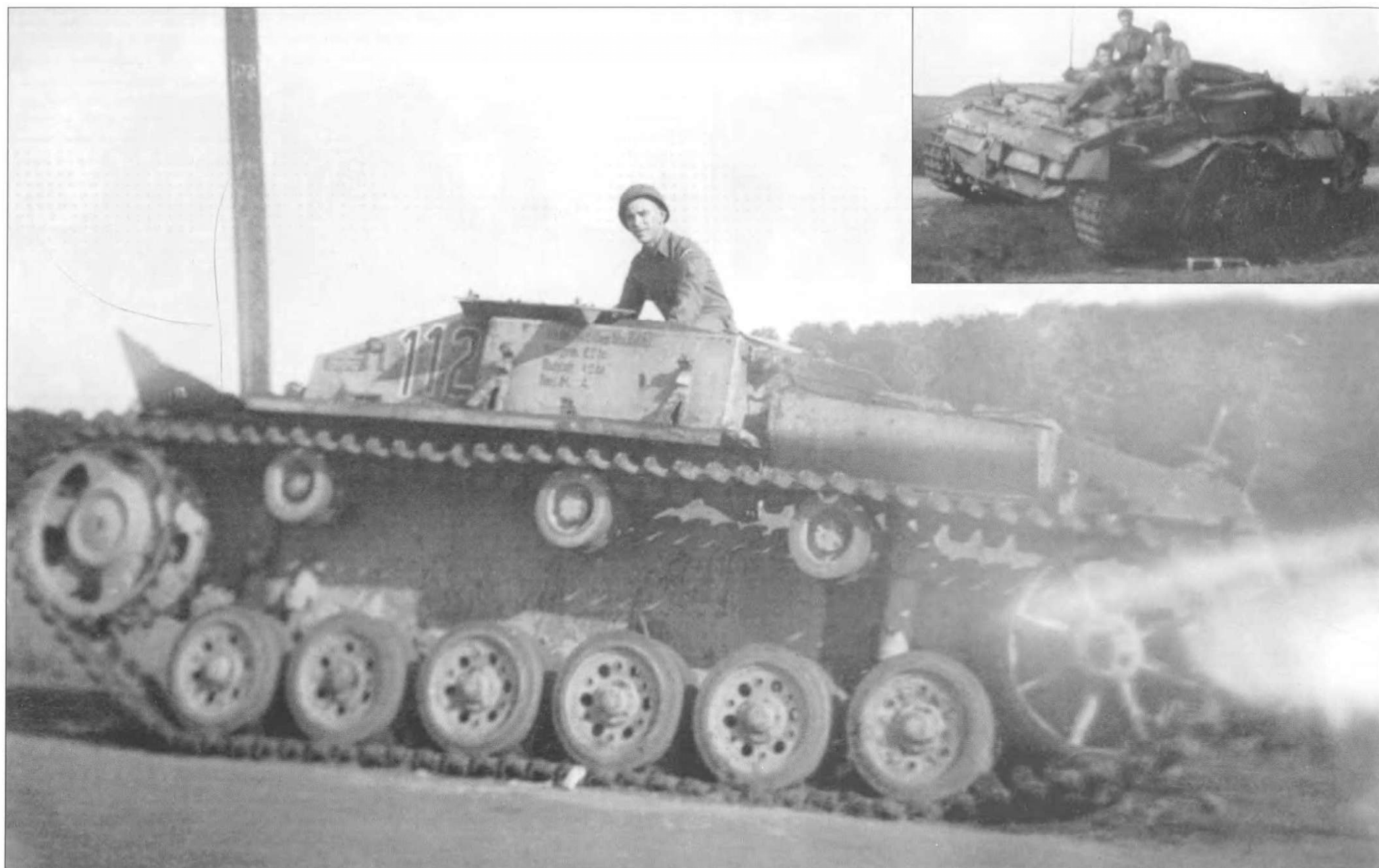
Два снимка предположительно одной и той же самоходки StuG III Ausf. E. Самоходка - одна, зато американцы разные. На каждого янки по истребительному орудию не напаешься! Машина-ветеран окрашена в темный песочно-зеленый цвет, без камуфляжа. Крылья погнуты и поломаны. Всего промышленность Рейха выдала на гора 284 истребительных орудий StuG III Ausf. E, после чего в марте 1942 г. переключилась на производство StuG III Ausf. F, вооруженных длинноствольными пушками StuK-40. На борту рубки написана некая спецификация, обычно здесь крепился банник.
