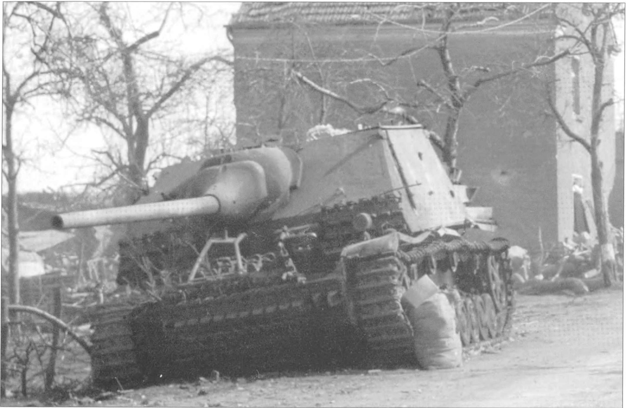
Очередной подбитый союзниками истребитель танков Panzer IV/70(A) из 7-й роты 2-го танкового полка, Химберг, 19 марта 1945 г., Германия. Внутренним взрывом вспучена крыша боевого отделения.
