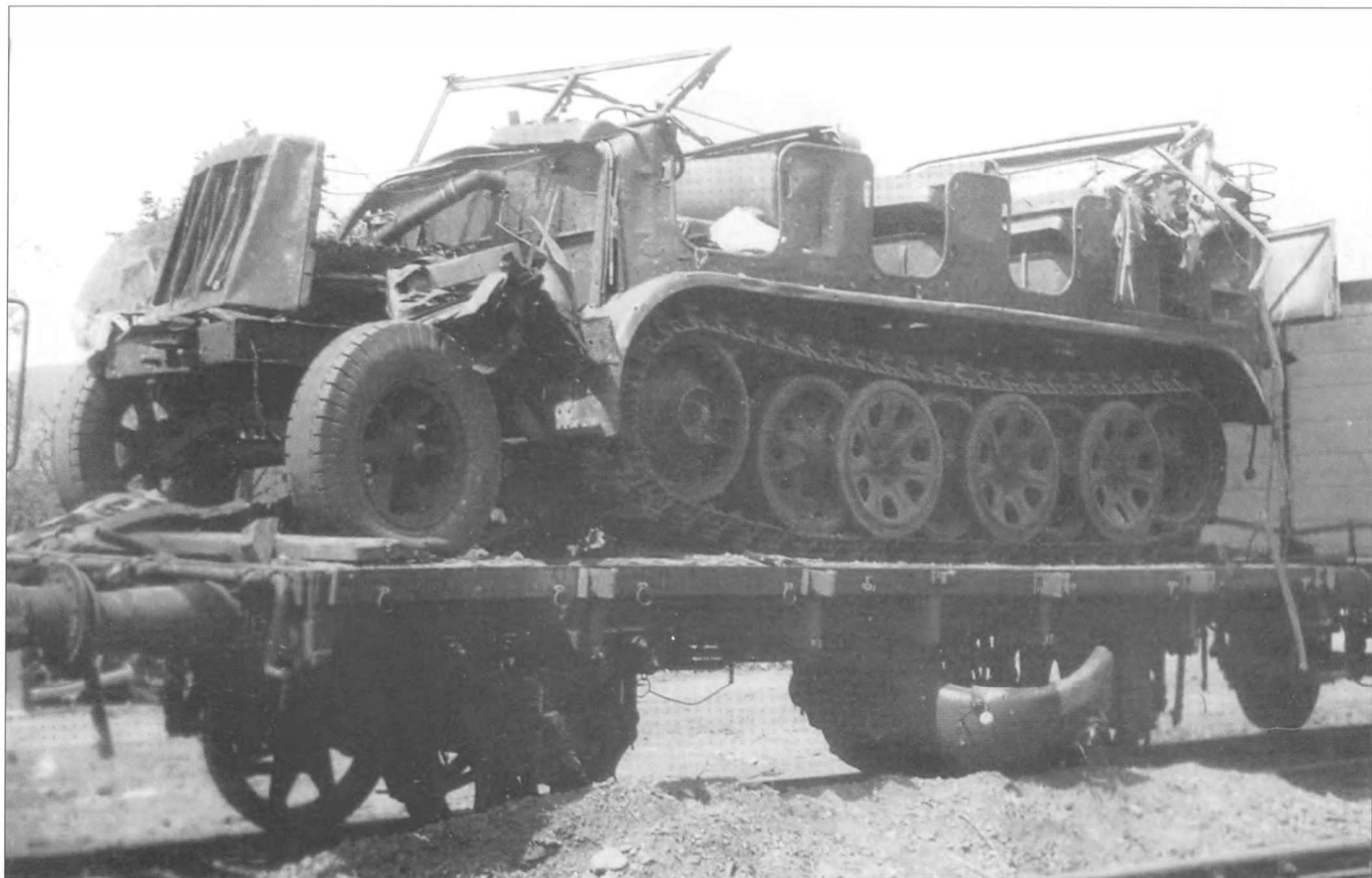
Артиллерийский тягач Sd.Kfz. 7 на железнодорожной платформе, Чехословакия, 1945 г. Снимок сделал фотолобитель из 704-го батальона истребителей танков армии США. Машина окрашена темнее стандартного цвета Dunkelgelb, скорее всего - в цвет Dunkelgrau. Одно крыло от тягача валяется на пути под вагоном.
