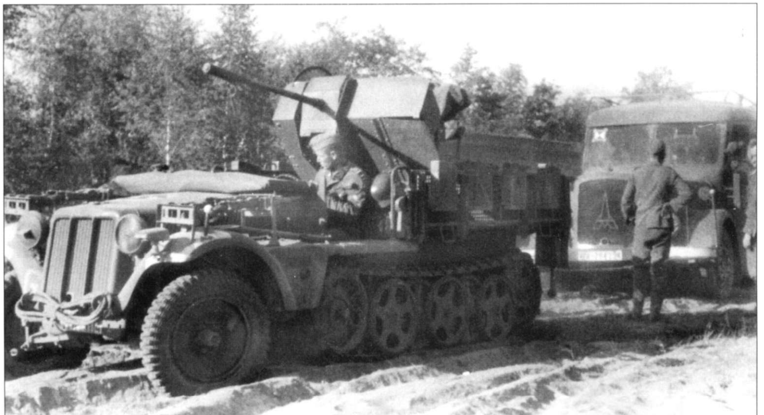
Зенитная самоходная установка Sd.Kfz. 10/4 буксирует грузовик Магирус (на радиаторе грузовика виден логотип фирмы). Борта кузова самоходки подняты. На крыле установлена фара Нотек. Ветровое стекло закрыто чехлом и откинута на капот мотора, чтобы отблески стекла не привлекали внимания наблюдателей противника.
