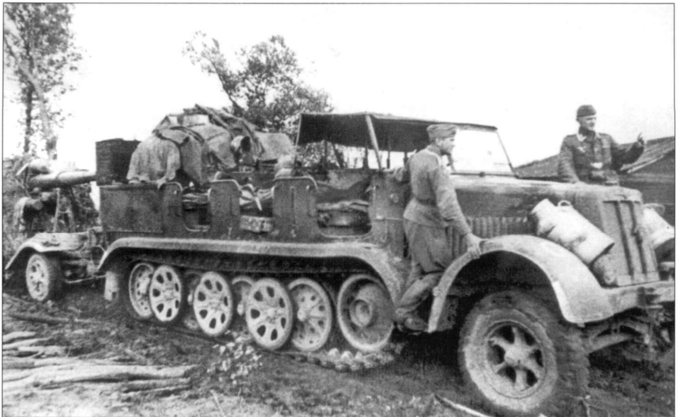
Тягач Sd.Kfz. 7 с прицепом в виде 88-мм зенитки FlaK18 на трейлере Sd.Ah. 201. На бортах кузова тягача остановлены вертикальные поручни. Тягач снабжен нестандартным тентом. Багажник машины завален скарбом, между крыльями и капотом двигателя заботливо пристроены два молочных бидона. Тягач оборудован фарой Нотек в дополнение к обычным фарам.
