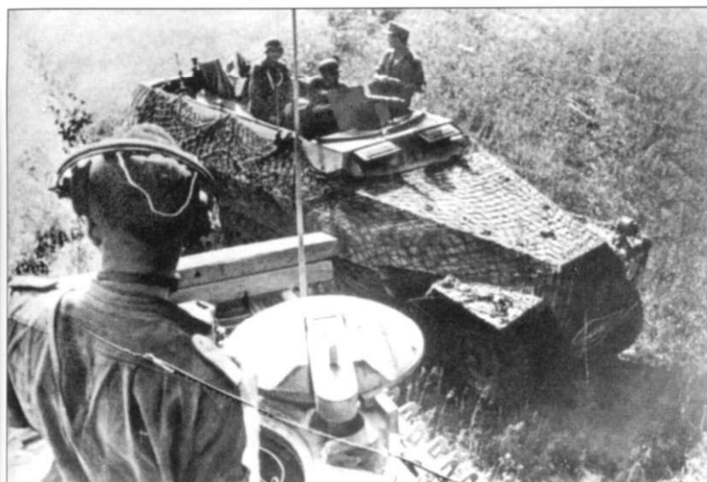
Командир танка «Пантера» с высоты осматривает бронетранспортер Sd.Kfz. 251 Ausf. D. Бронетранспортер накрыт маскировочной сетью. Пулемет MG42 снабжен бронещитком. На крыльях броневика стоят фары Бош.
