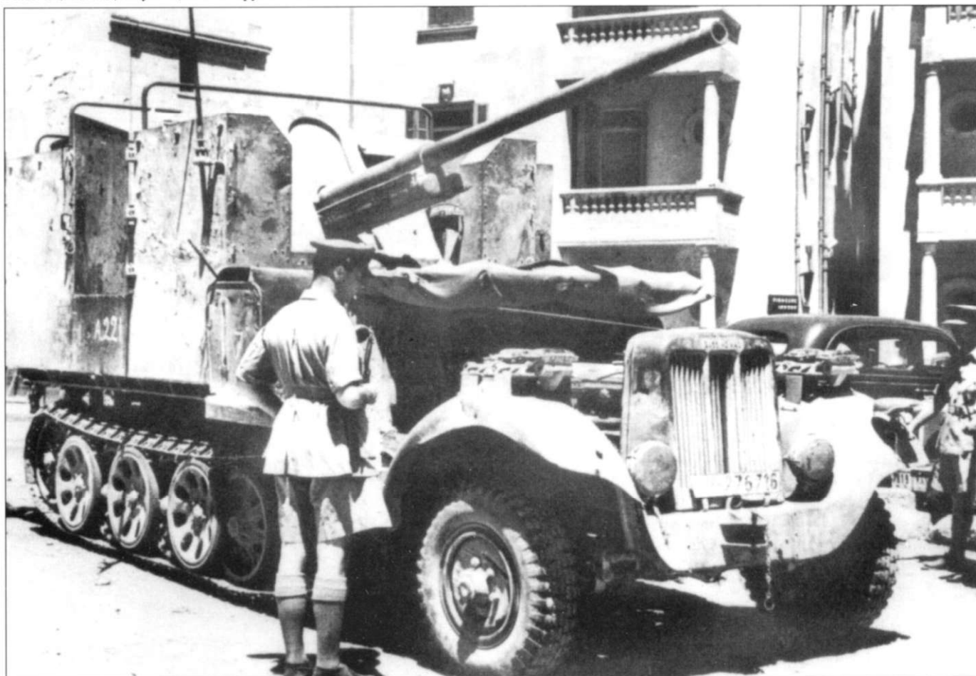
На базе шасси BN9b фирмы Бюссинг-Наг было изготовлено девять самоходно-артиллерийских установок 7.62 см F.K. (r) auf gr. Selbstfahrlafette (Sd.Kfz. 6/3). В марте 1942 г. все построенные самоходки переправили в Северную Африку, где они поступили на вооружение Panzer-Jäger-Abteilung 605. Самоходчики доносили, что самоходки с трофейными русскими пушками способны расчленивать британские танки «Матильда», неуязвимые для германских противотанковых и танковых пушек. В то же время шасси тягача было сильно перегружено пушкой и бронированием, хотя броня защищала только от пуль. В отличие от более поздних германских экспериментов с трофейными советскими пушками, эти орудия не переделывались под германские снаряды. Возможность поражения движущихся целей самоходками Sd.Kfz. 6/3 в силу ряда причин была очень и очень низкой.
