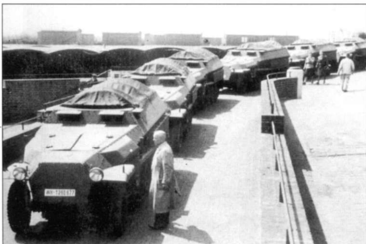
Колонна бронетранспортеров Sd.Kfz. 251/1 Ausf. C покидает завод. Клепанные корпуса имело очень небольшое количество бронетранспортеров варианта Ausf. C. Кузова всех машин закрыты тентами, натянутыми на скобы. Фары обычного типа ничем не закрыты, нет инструмента на бортах, не установлены щитки передних пулеметов и фары Нотек.
