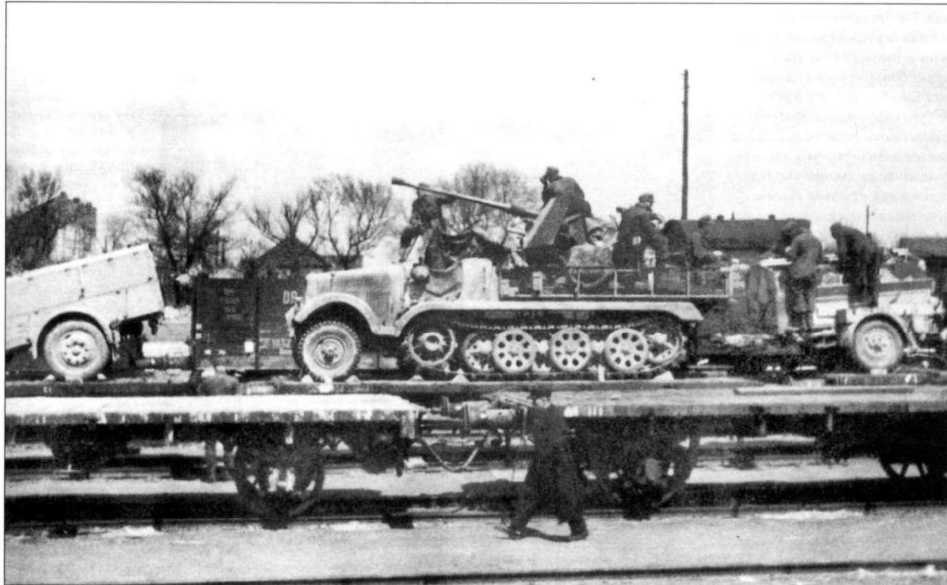
Тягач Sd.Kfz. 6/2, вооруженный зениткой 3.7 см FlaK36/37 установленной на платформе взамен кузова. Борта сняты перед погрузкой на железнодорожную платформу. Боекомплект к пушке перевозился в прицепе Sonderanhänger Sd.Ah.57, тягач зафиксирован на платформе деревянными блоками.
