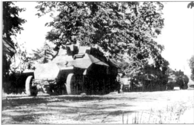
Колонна бронетехники. На переднем плане - машина огневой поддержки Sd.Kfz. 251/9 . Техника остановилась под прикрытием деревьев во избежание обнаружения авиацией противника. На крыле установлена фара Бош, правая бронезаслонка заменена неподвижной заглушкой.
