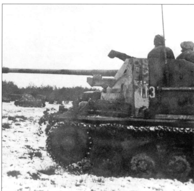
Несколько снимков самоходок Marder II (Sd.Kfz. 131), сделанных зимой. Обычное дело - в лобовой части корпуса закреплены запасные опорный каток и гусеничные траки. На всех машинах пулеметы MG-34 приведены в боевое положение. Фотографии сделаны в самом начале зимы - самоходки еще не успели перекрасить в белый цвет. Истребители танков камуфлированы красно-коричневыми и оливково-зелеными пятнами-полосами по темно-желтому фону. Номера машин - «113», «122», цифры тактических номеров - белые.
