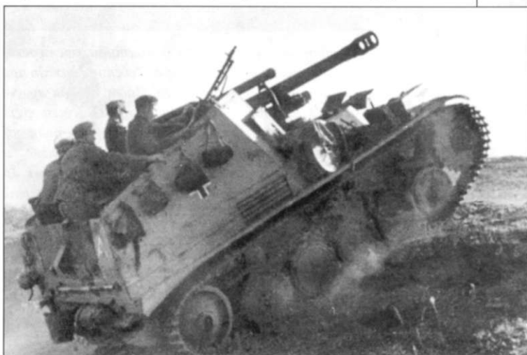
САУ «Веспе» с установленном на щите рубке пулеметом МГ-34. На борту рубки подвешены подсумки членов экипажа, обычно в таких подсумках солдаты носили сухой паек. На снимке - орудие «А», 1-е в батарее.
