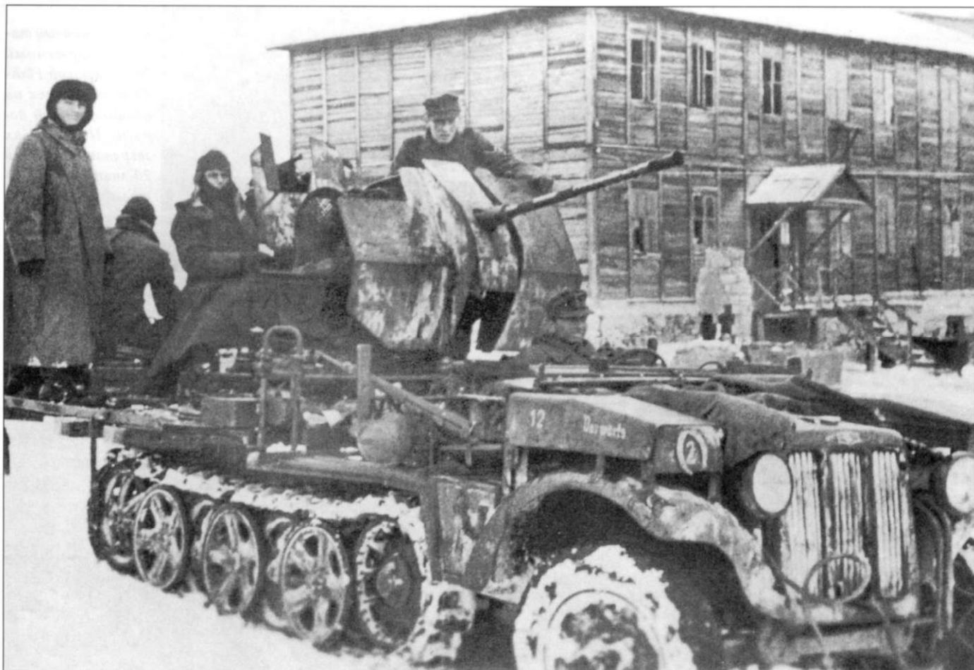
3CV Sd.Kfz. 10/5, вооруженная пушкой 2 см FlaK-38 L/112. Удивительно, но на машине сохранился колпак, которым закрываются карабины над крылом переднего колеса. На колпаке белой краской выполнена какая-то надпись в готическом стиле, вероятно - «Vorwärts». В частях пушки FlaK-38 на самоходках Sd.Kfz. 10/5 иногда заменяли 50-мм противотанковыми орудиями PaK-38.
