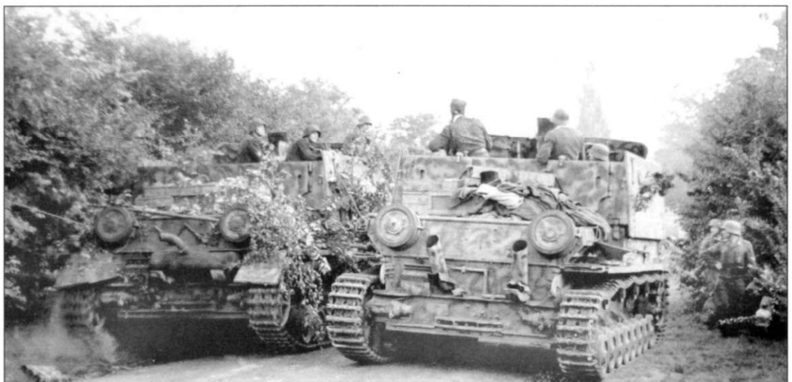
Два снимка ЗСУ «Мобельваген», вооруженной 37-мм пушкой FlaK-43. Самоходки «Мобельваген» строились на шасси танков Pz.Kpfw. IV. Полное название ЗСУ - 3.7 cm FlaK auf Fahrgestell Panzerkampfwagen IV (Sf.) (Sd.Kfz. 161/3). Первые 20 рубок были изготовлены из двойных бронелистов толщиной 12 мм каждый, следующие 25 - из двойных бронелистов толщиной по 10 мм, остальные сделали из одинарных бронелистов толщиной 25 мм. Стенки рубки выполнялись откидными, но работать с пушкой можно было и при поднятых стенках. Самоходка камуфлирована полосами оливково-зеленого и красно-коричневого цвета по темно-желтому фону.
